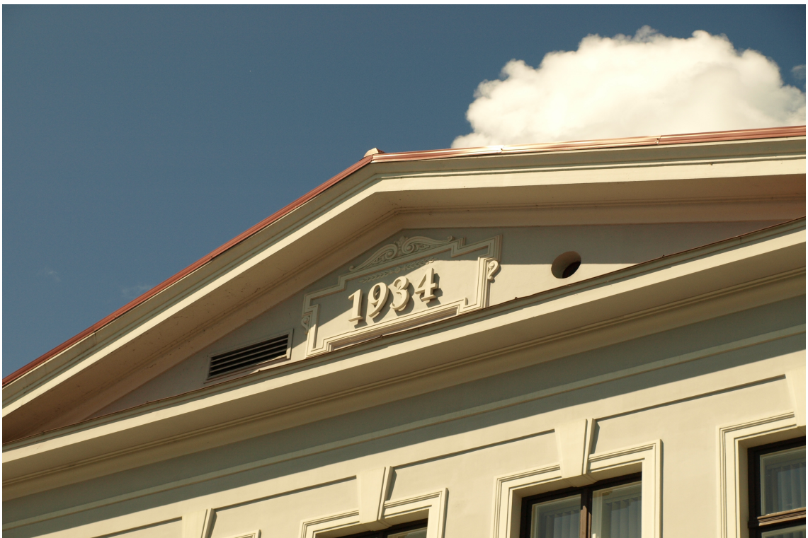
Dzirnavu_5_62010140016001_fragments1 Galvenās fasādes fragments ar sākotnējām (1934.g.) dzegām un 20.gs.2.pusē izveidoto frontona dekoru.
