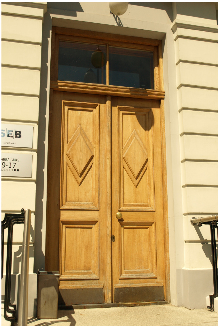
Dzirnavu_5_62010140016001_durvis1 Sākotnējo (1934.g.) durvju komplekts ar oriģinālo aprīkojumu.
