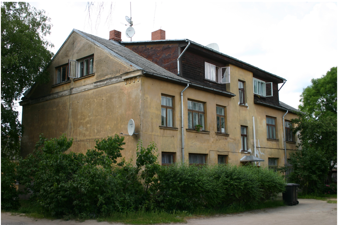
Dzirnavu_4_62010230039001_fasade2 Skats uz ēku no dienvidaustrumiem. Jumta izbūve – 20.gs.2.puse.
