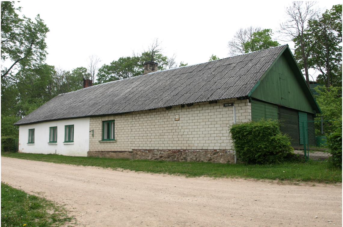
Diikju_4_62010220007001_fasade2 Skats uz ēku no dienvidaustrumiem.
