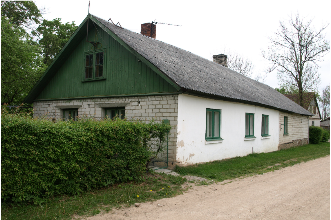
Diikju_4_62010220007001_fasade1 Skats uz ēku no dienvidrietumiem.
