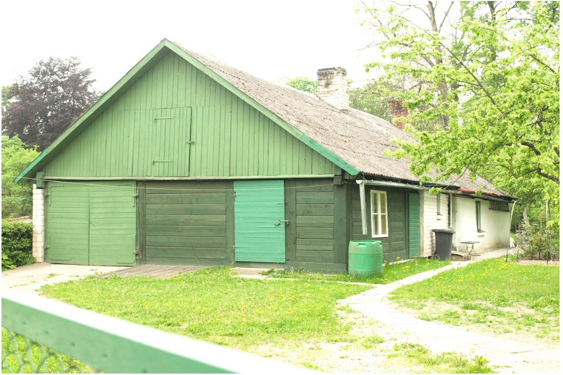
Diikju_4_62010220007001_fasade3 Skats uz ēku no ziemeļaustrumiem.
