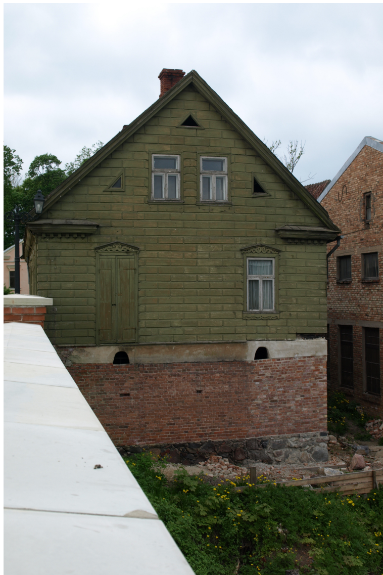
Bazniicas_36_62010220045006_fasade3 Skats uz ēkas ziemeļaustrumu fasādi.
