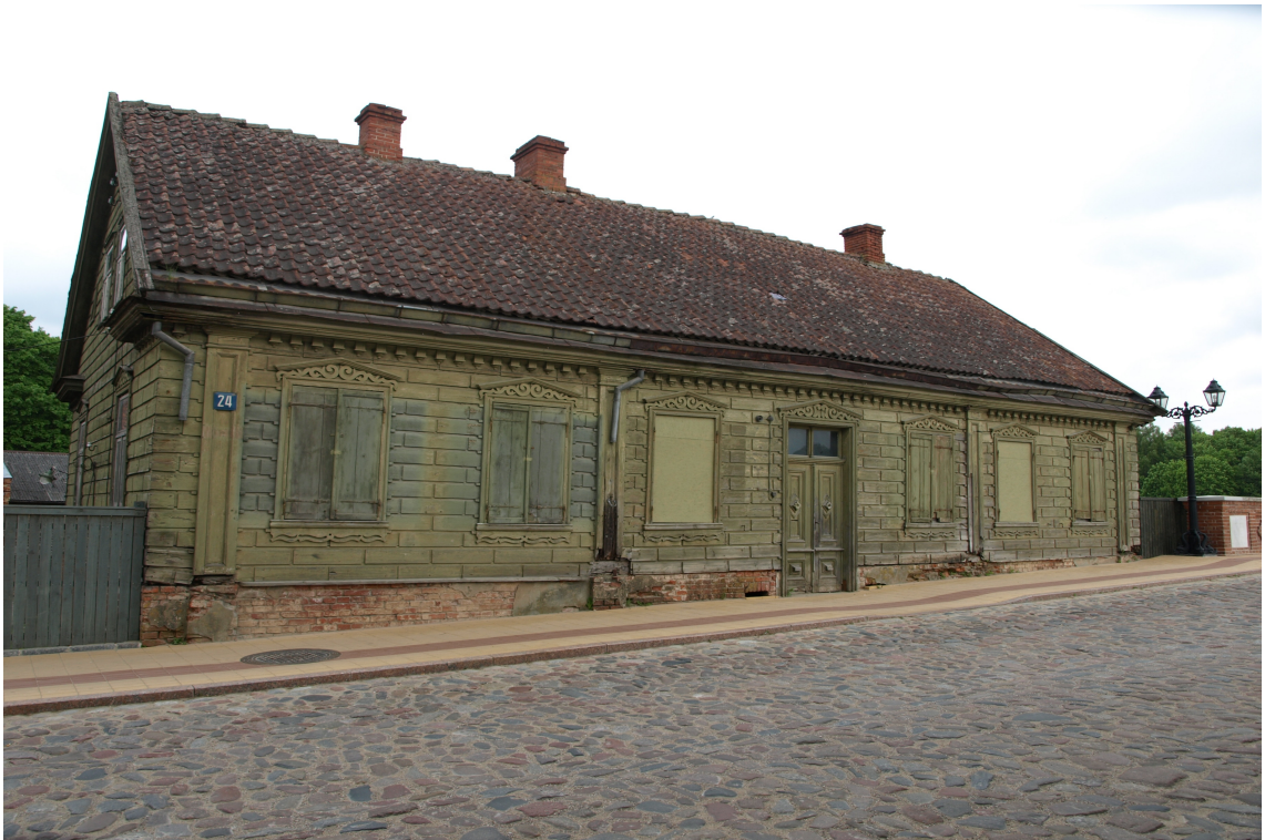
Baznīcas_36_62010220045006_fasade2 Skats uz ēku no dienvidiem.
