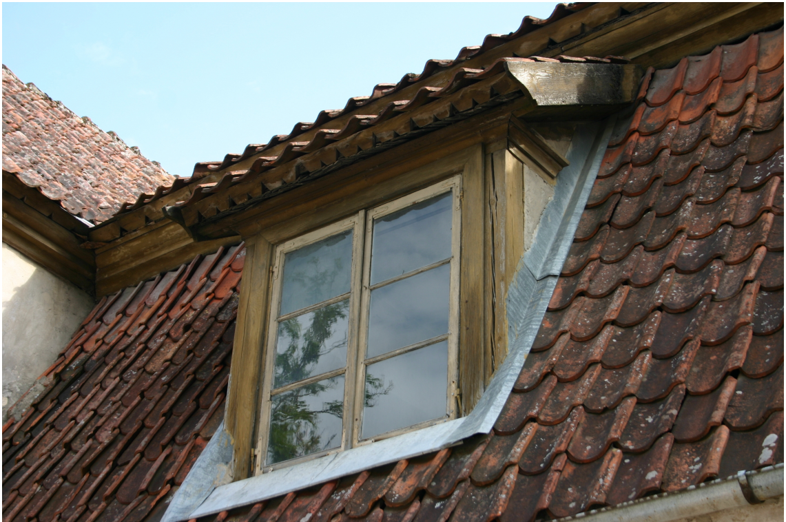
Bazniicas_36_62010220045001_fragments1 19.gs.3.cet. jumta izbūve ar oriģinālo logu un tā aprīkojumu.
