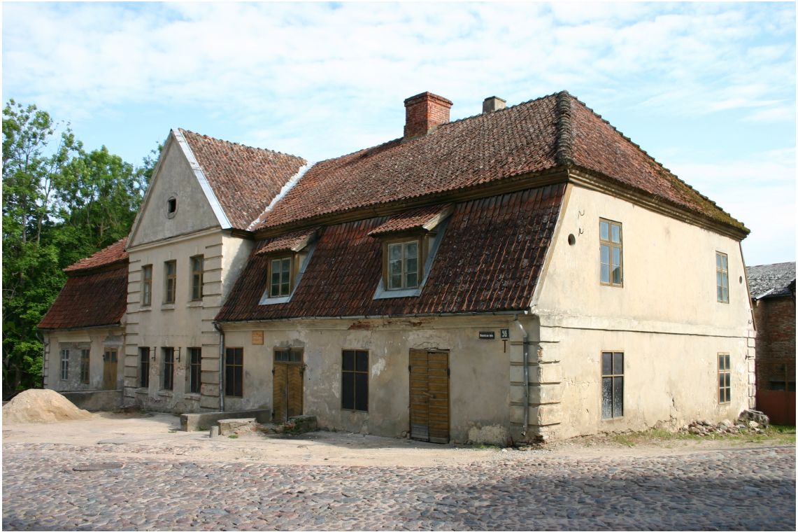
Bazniicas_36_62010220045001_fasade1 Skats uz ēku no dienvidiem. Jumta izbūves – 19.gs.3.cet.
