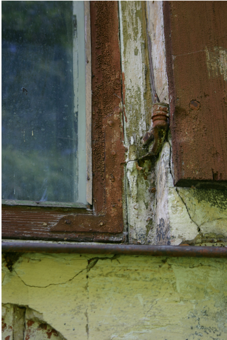
Baznīcas_34_62010060074001_logs2 19.gs.3.cet. loga vira un slēga viras kāsis.
