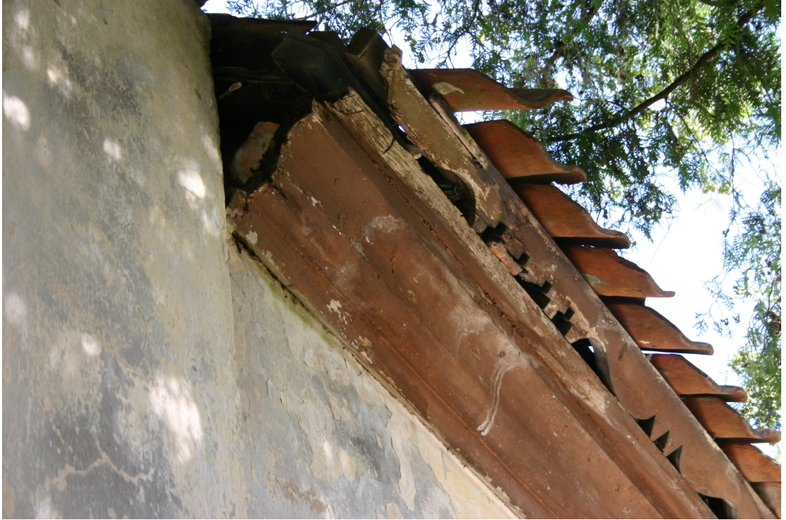
Bazniicas_34_62010060074001_dzega2 Vēsturiska dzega no viena dēļa un 20.gs.1.cet. (pēc 1913.g.) kokā griezts aizsegdēlis.
