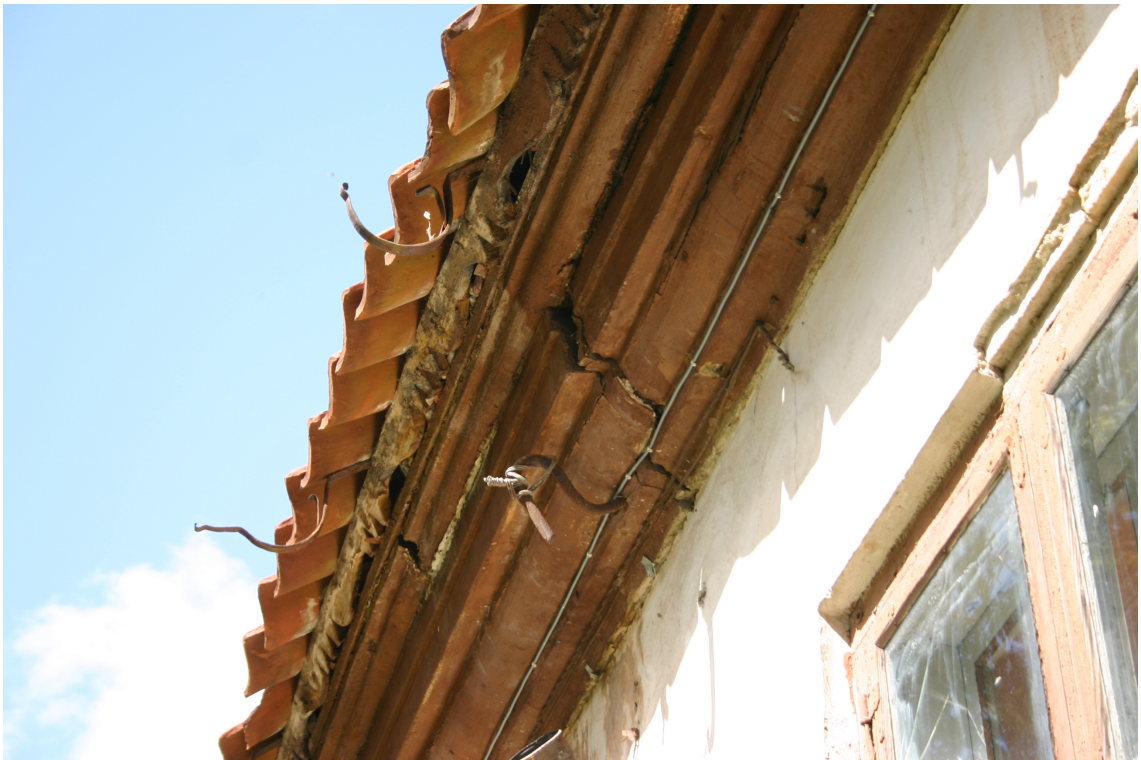
Baznīcas_34_62010060074001_dzega1 Sākotnēja koka dzega un vēsturisks kokā griezts aizsegdēlis.
