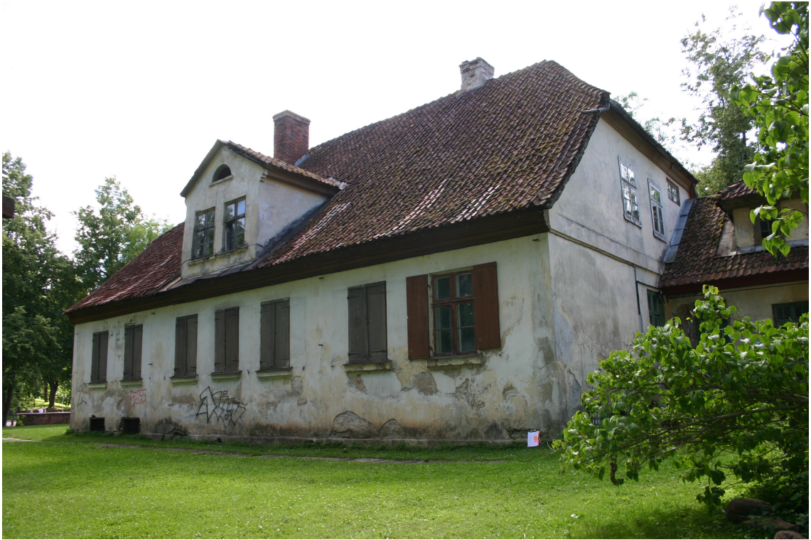
Bazniicas_34_62010060074001_fasade5 Skats uz ēku no ziemeļaustrumiem. Mezonīns – 19.gs.beigas.
