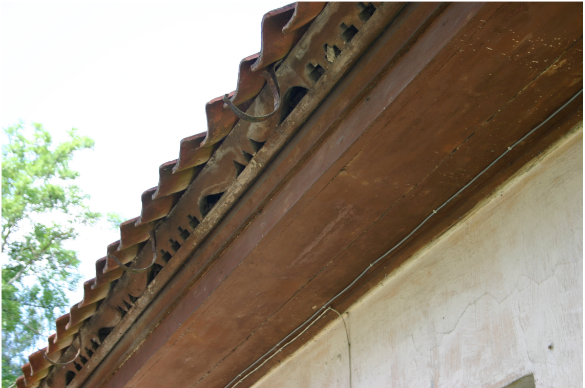
Bazniicas_34_62010060074001_dzega3 20.gs.1.cet. (pēc 1913.g.) dēļu dzega un aizsegdēlis.
