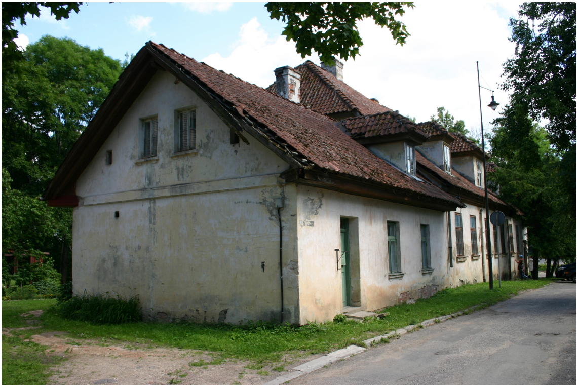
Bazniicas_34_62010060074001_fasade6 Skats uz ēku no ziemeļrietumiem. Piebūve un jumta izbūves - 20.gs.1.cet. (pēc 1913.g.).
