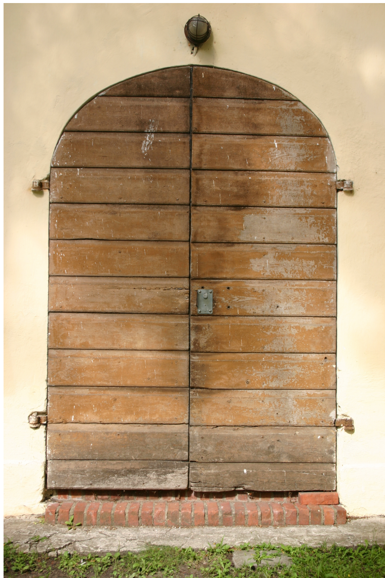
Baznīcas_33_62010060031001_durvis7 Vēsturiskas durvis ar daļēji saglabājušos aprīkojumu.
