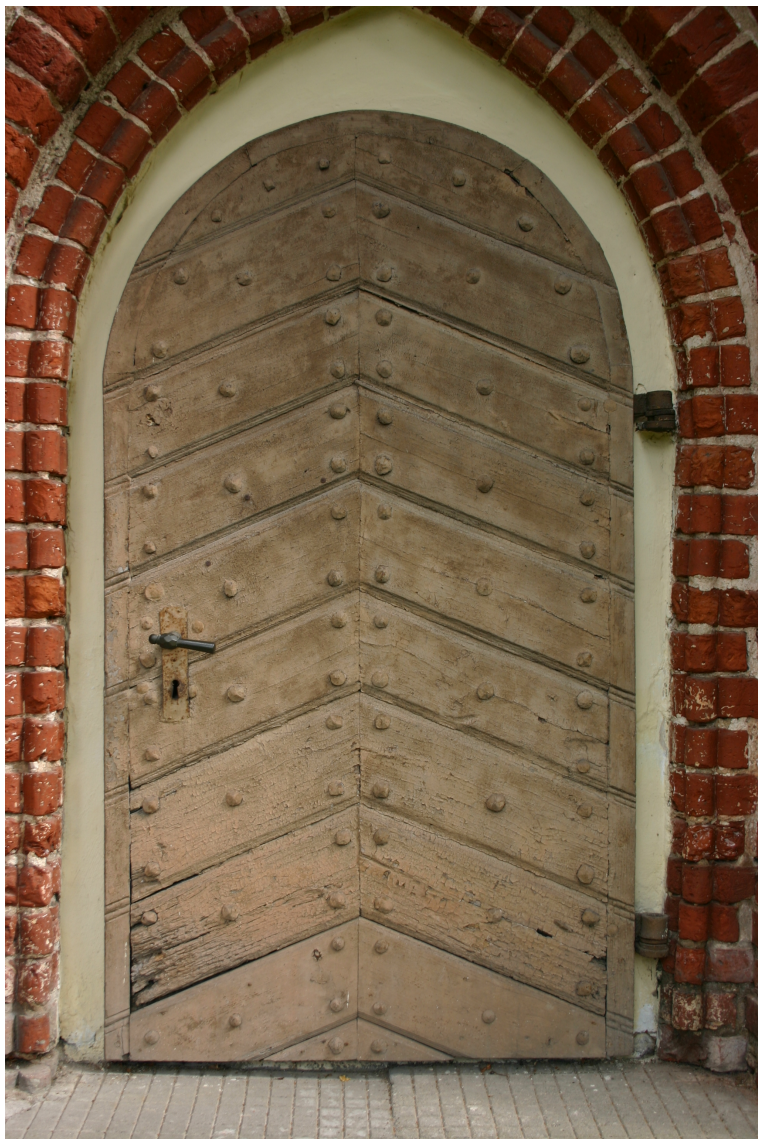
Baznīcas_33_62010060031001_durvis1 18.gs. durvis ar vēsturisku aprīkojumu.
