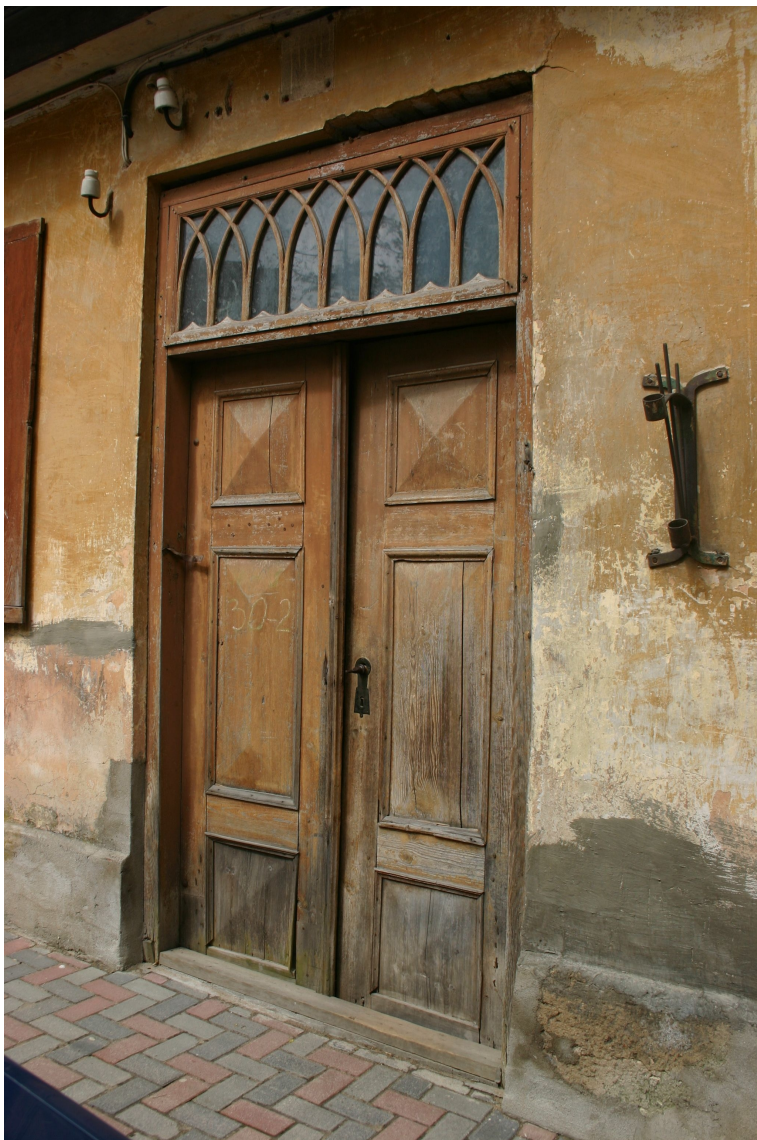
Baznīcas_30_62010060007001_durvis1 Sākotnējs (19.gs.3.cet.) durvju komplekts ar oriģinālo aprīkojumu.
