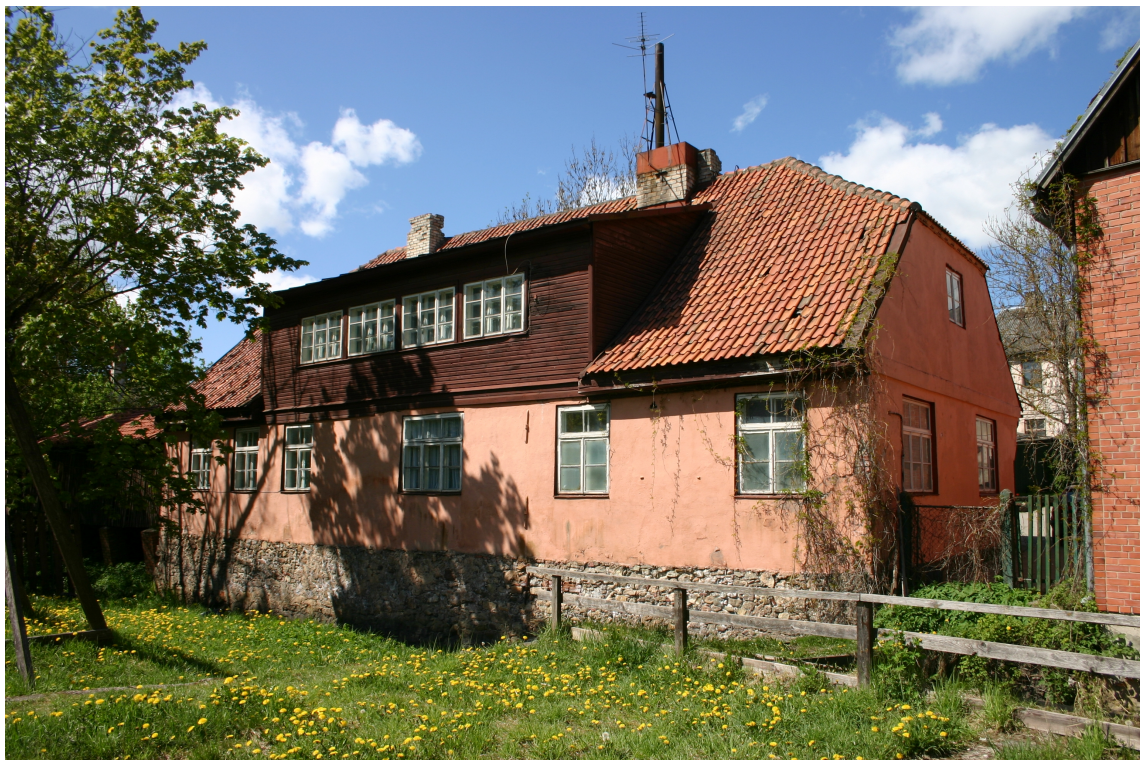
Bazniicas_29_62010060006006_fasade2 Skats uz ēku no austrumiem. Jumta izbūve izveidota 20.gs.2pusē.
