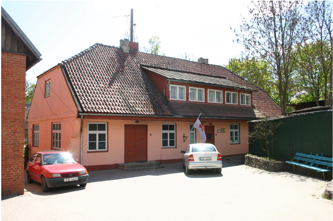
Bazniicas_29_62010060006006_fasade1 Skats uz ēku no ziemeļiem. Jumta izbūve izveidota 20.gs.2pusē.
