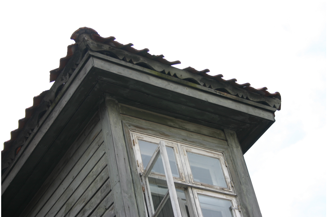
Bazniicas_28_62010060023001_fragments1 Jumta izbūve ziemeļu fasādē (20.gs.2.puse).
