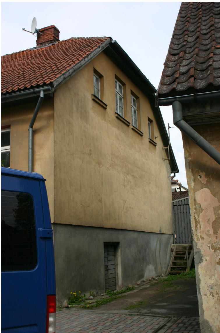
Bazniicas_28_62010060023001_fasade3 Ēkas austrumu fasāde.
