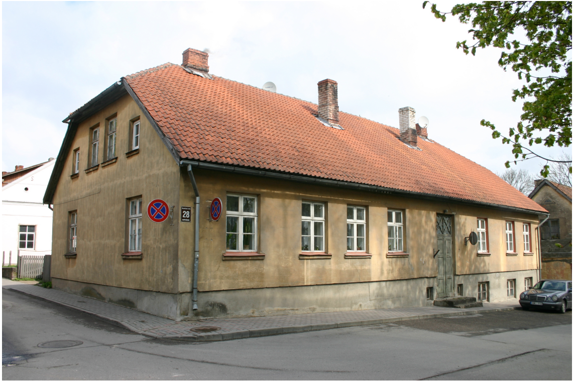
Baznīcas_28_62010060023001_fasade1 Skats uz ēku no dienvidrietumiem.
