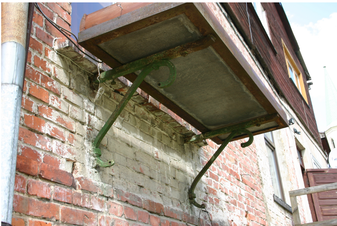
Baznīcas_27_62010060005001_detala1 20.gs.sāk. metāla konsoles.
