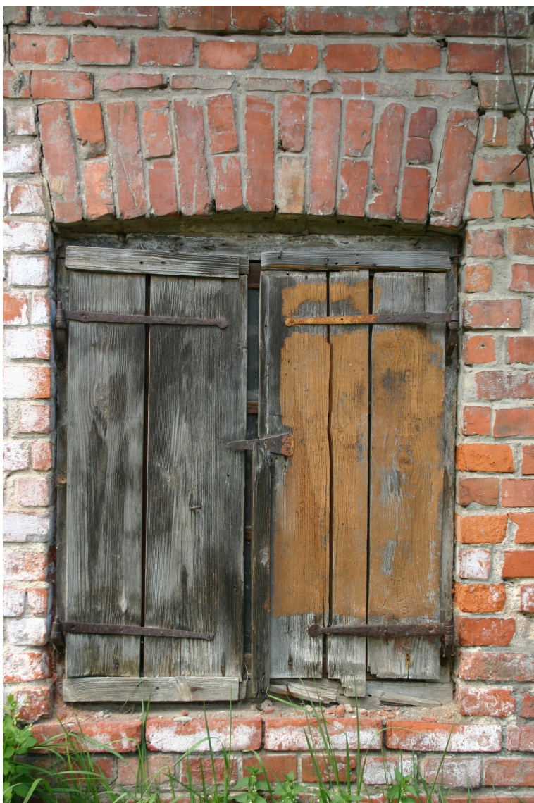
Baznīcas_27_62010060005001_slegi1 20.gs.10.,20.gados (pēc 1913.g.) logs un slēgi ar oriģinālo aprīkojumu.
