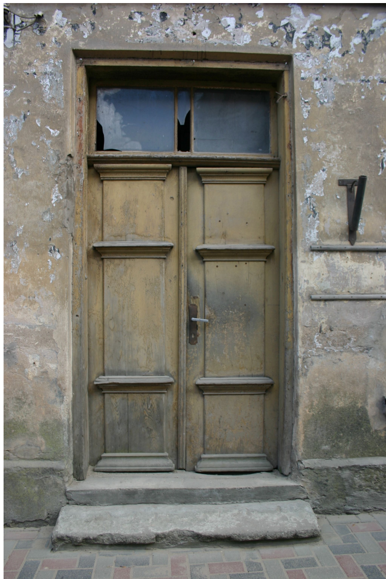
Baznīcas_23_62010060073001_durvis1 Sākotnējs (1870to gadu sāk. - 1879.g.) durvju komplekts ar oriģinālo atslēgas cauruma nosegvairodziņu.
