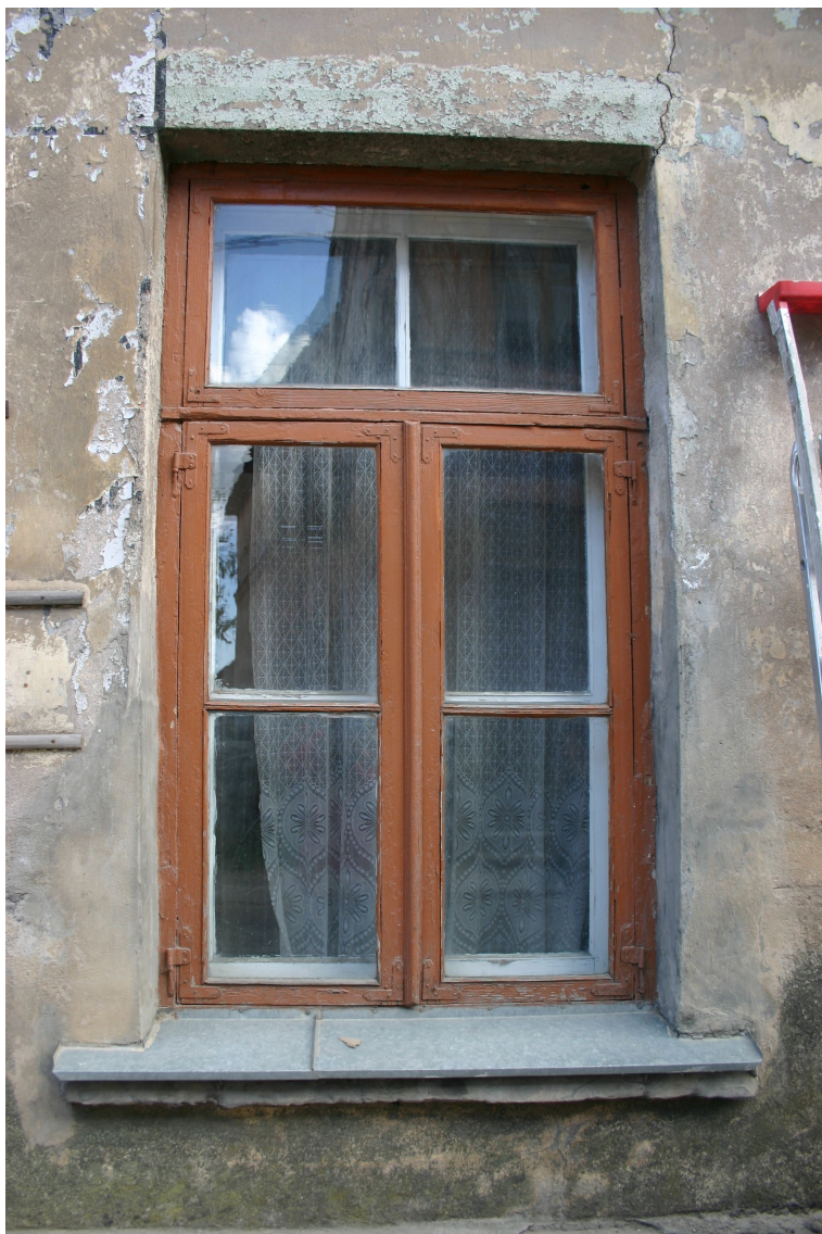
Baznīcas_23_62010060073001_logs1 20.gs.sāk. logs ar oriģinālo aprīkojumu.
