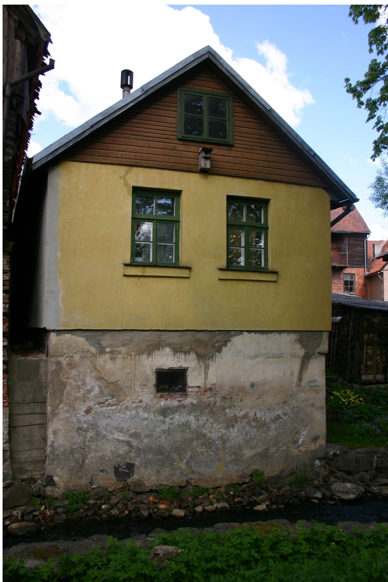
Baznīcas_21a_62010060076001_fasade2 Ēkas dienvidaustrumu fasāde.
