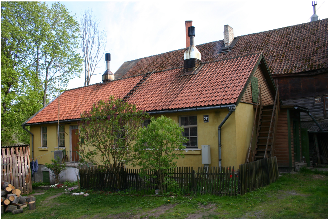
Baznīcas_21a_62010060076001_fasade1 Skats uz ēku no ziemeļiem.
