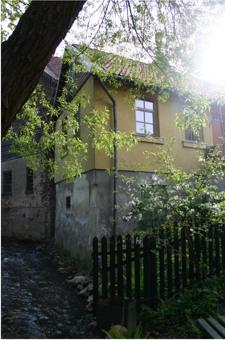
Baznīcas_21a_62010060076001_fasade3 Ēkas austrumu stūris.
