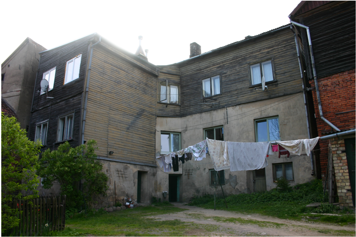
Baznīcas_21_62010060027001_fasade3 Skats uz ēku no austrumiem. Piebūve uzcelta 19.gs.pēd.cet.
