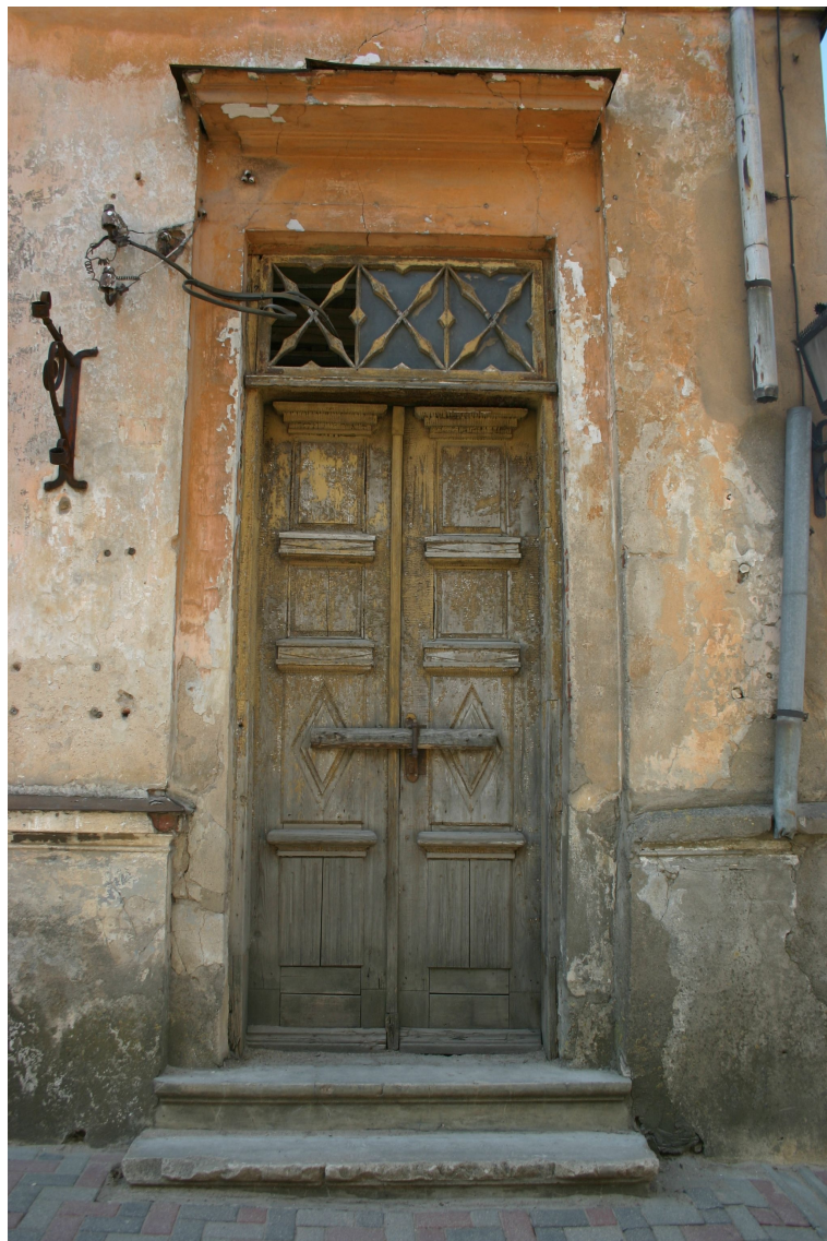
Bazniicas_20_62010060066001_durvis1 Sākotnējs (19.gs.3.cet.) durvju komplekts (iespējams, izmantotas vecākas vērtnes, kas pārveidotas)
