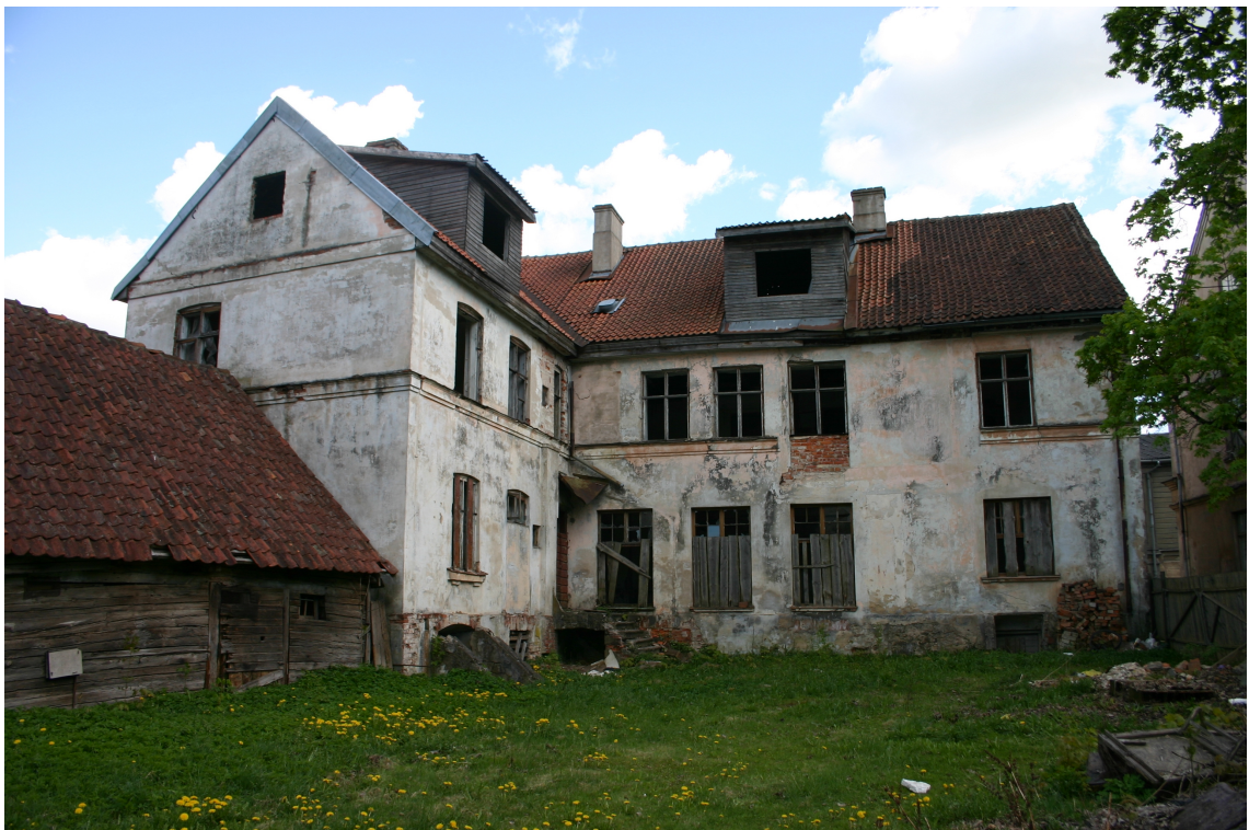
Bazniicas_20_62010060066001_fasade4 Skats uz ēku no ziemeļrietumiem. Kreisajā pusē esošā piebūve uzcelta nedaudz vēlāk par pamatapjomu.
