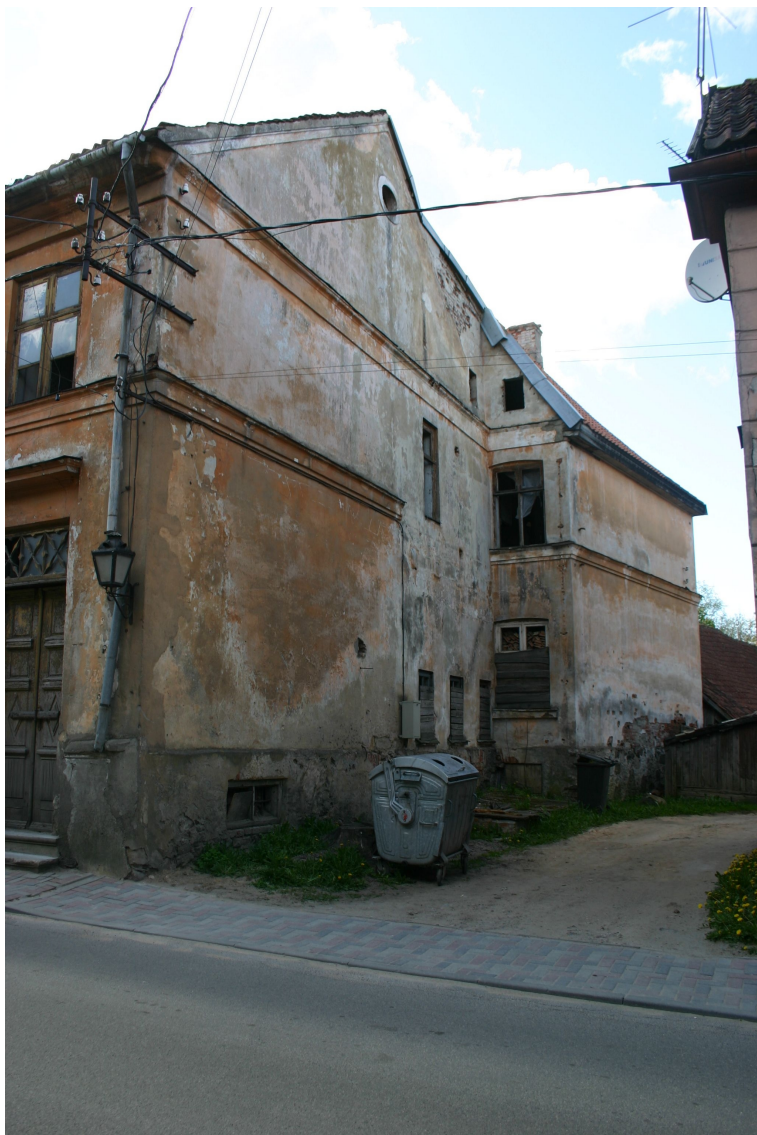
Baznīcas_20_62010060066001_fasade2 Skats uz ēkas ziemeļaustrumu fasādi. Dzīlumā redzamā piebūve uzcelta nedaudz vēlāk par pamatapjomu.
