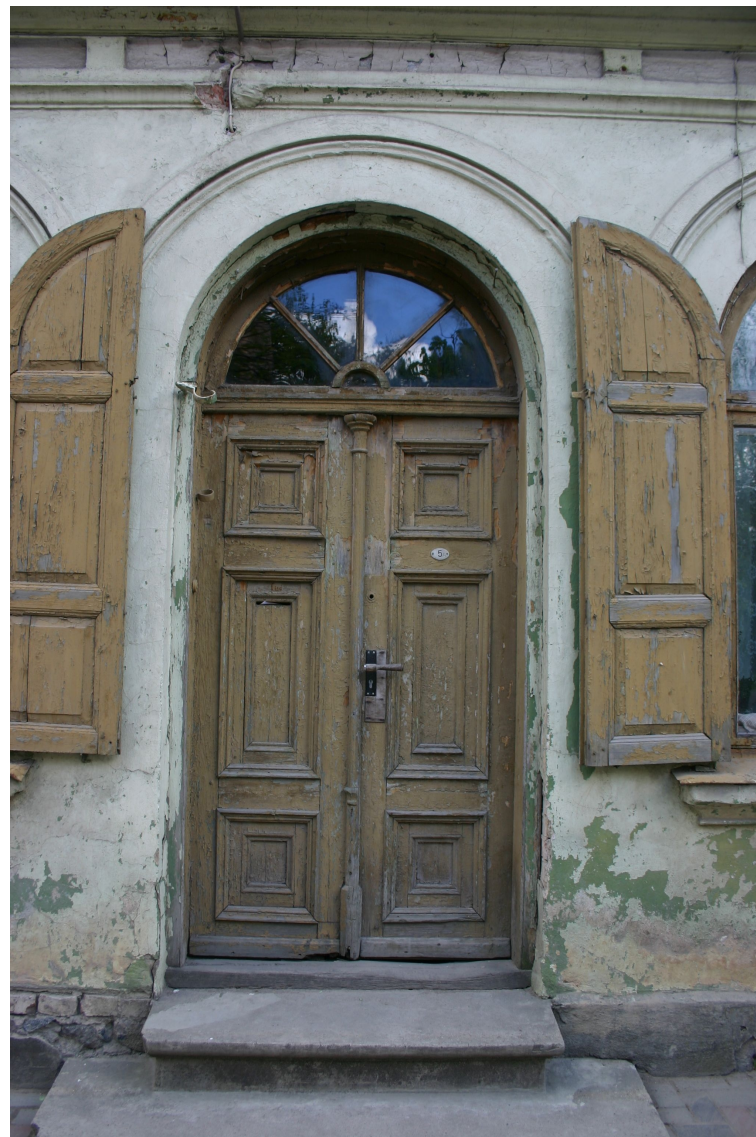
Baznīcas_19_62010060072001_durvis1 Sākotnējs (19.gs.pēd.cet., pēc 1879.g.) durvju komplekts.
