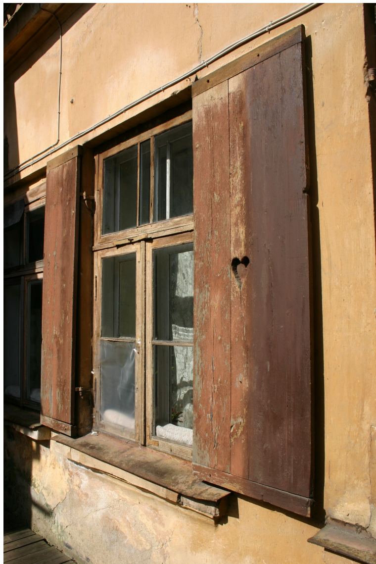
Bazniicas_19_62010060072001_logs2 Sākotnējs (19.gs.pēd.cet., pēc 1879.g.) logs un slēgi ar oriģinālo aprīkojumu pagalma fasādē.
