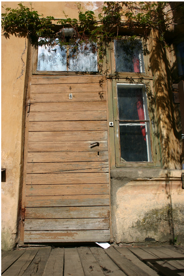
Baznīcas_19_62010060072001_fragments1 Vēsturisks durvju komplekts un logs ar oriģinālo aprīkojumu.
