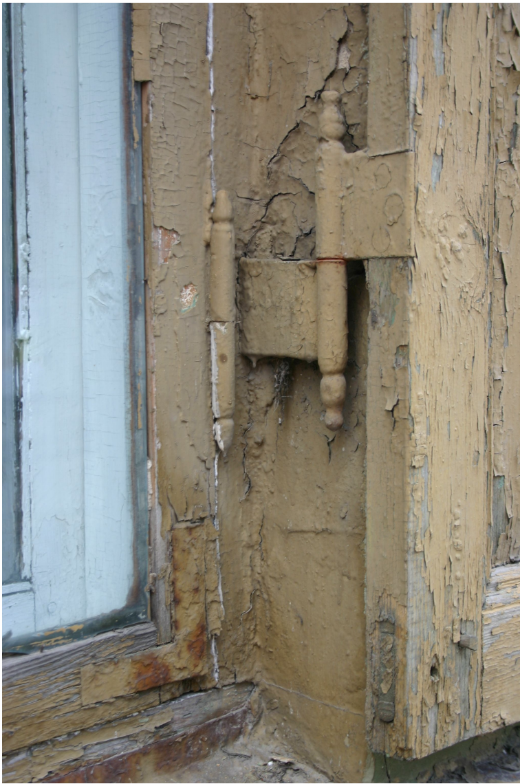
Bazniicas_19_62010060072001_detala1 Sākotnējs (19.gs.pēd.cet., pēc 1879.g.) loga aprīkojums un slēga vira ielas fasādē.
