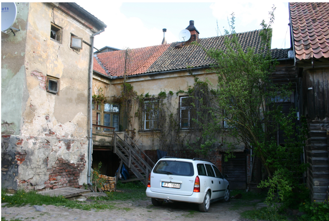
Baznīcas_19_62010060072001_fasade4 Skats uz sākotnējiem (19.gs.pēd.cet., pēc 1879.g.) pagalma korpusiem.
