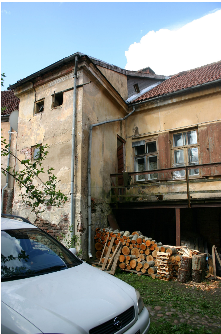
Baznīcas_19_62010060072001_fasade3 Skats uz pagalma fasādi un sākotnējo tualešu korpusu no austrumiem.
