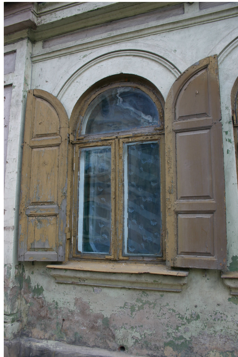
Bazniicas_19_62010060072001_logs1 Sākotnējs (19.gs.pēd.cet., pēc 1879.g.) logs un slēģi ar oriģinālo aprīkojumu ielas fasādē.
