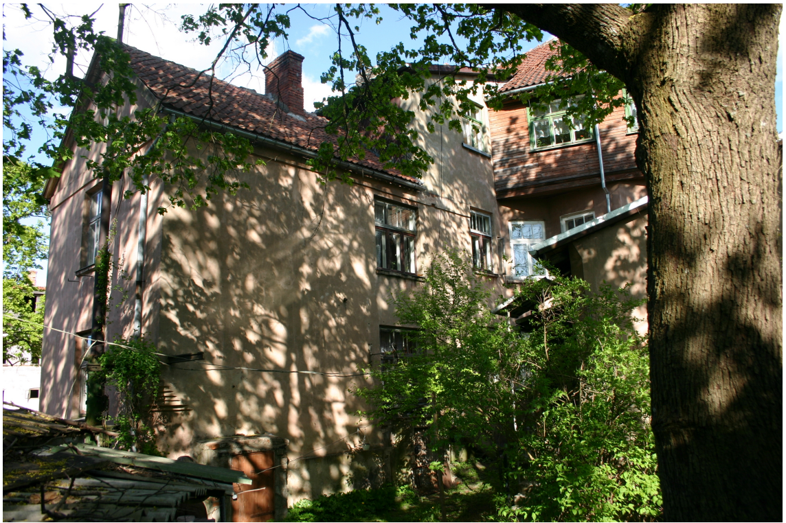
Bazniicas_18_62010060065001_fasade5 Sākotnējās (19.gs.3.cet.) piebūves dienvidrietumu fasāde. Jumta izbūves – 20.gs.2.puse.
