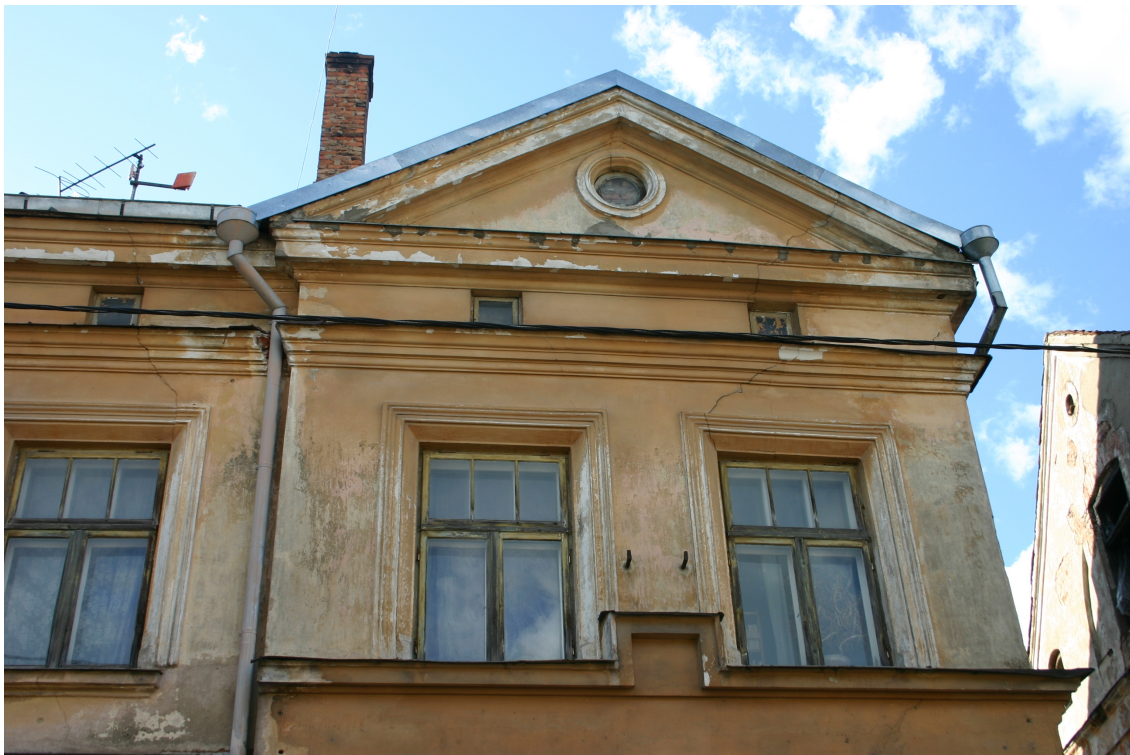
Baznīcas_18_62010060065001_fragment1 Galvenās fasādes fragments ar sākotnējo (19.gs.3.cet.) dekoratīvo apdari. Atkā un zelminī sākotnējie logi.
