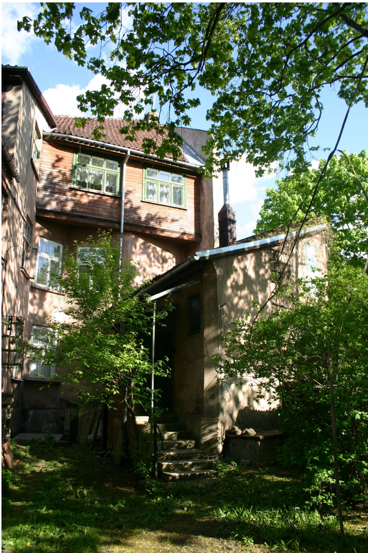
Bazniicas_18_62010060065001_fasade6 20.gs.20.gados celtās un 20.gs.2.pusē pārbūvētās piebūves.
