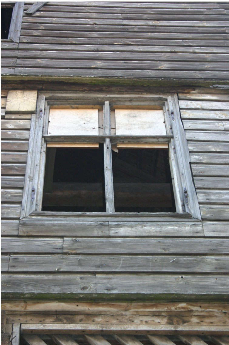
Baznīcas_17_62010060058002_logs1 Sākotnējā (19.gs.b.) loga aploda ar oriģinālajiem loga un slēģu viru kāšiem.
