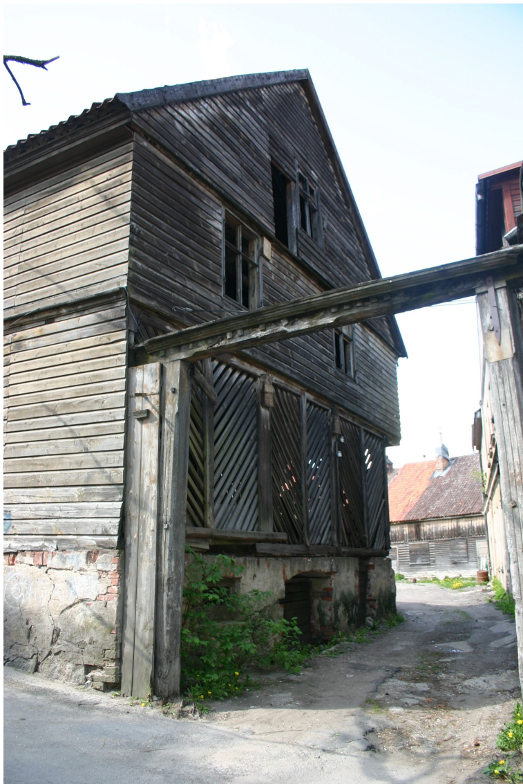
Baznīcas_17_62010060058002_fasade2 Skats uz ēkas austrumu fasādi. Redzama vēsturiska vārtu aila.
