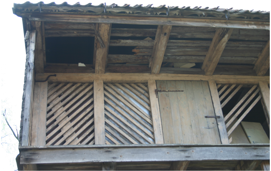
Baznīcas_17_62010060058002_fragment1 Ziemeļu fasādes fragments ar sākotnējo (19.gs.b.) apdari un durvīm, kurām oriģinālais aprīkojums.
