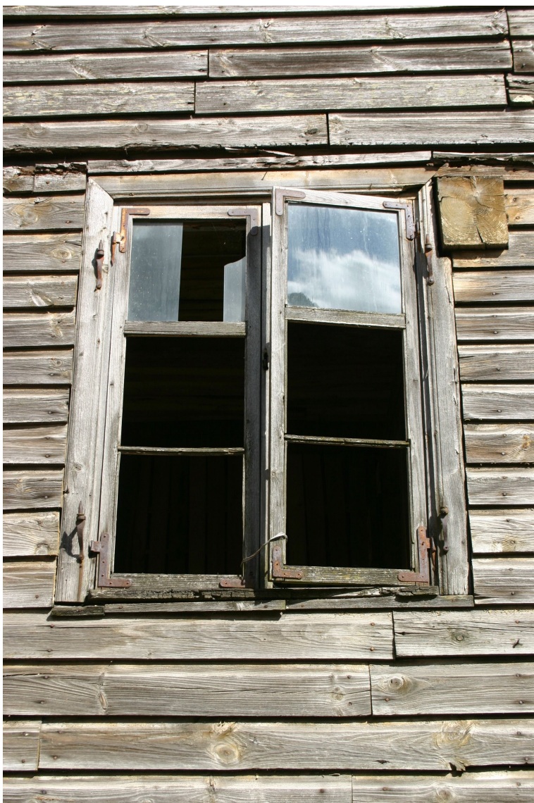
Bazniicas_17_62010060058002_logs2 Vēsturisks logs ar oriģinālo aprīkojumu un slēgu viru kāšiem.
