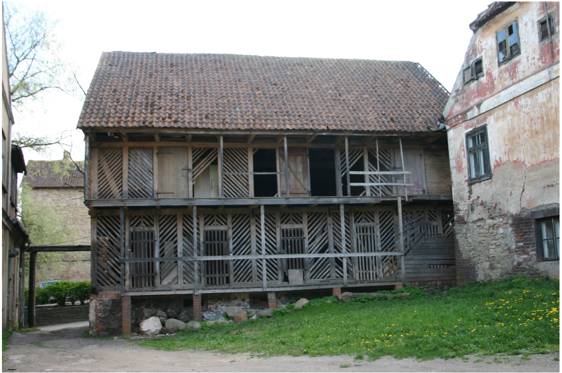
Baznīcas_17_62010060058002_fasade1 Skats uz ēkas ziemeļu fasādi.
