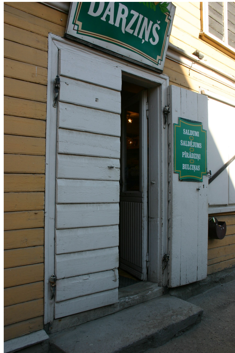
Baznīcas_15_62010060002001_slegi2 20.gs.sāk. durvju slēģi ar oriģinālajām virām.
