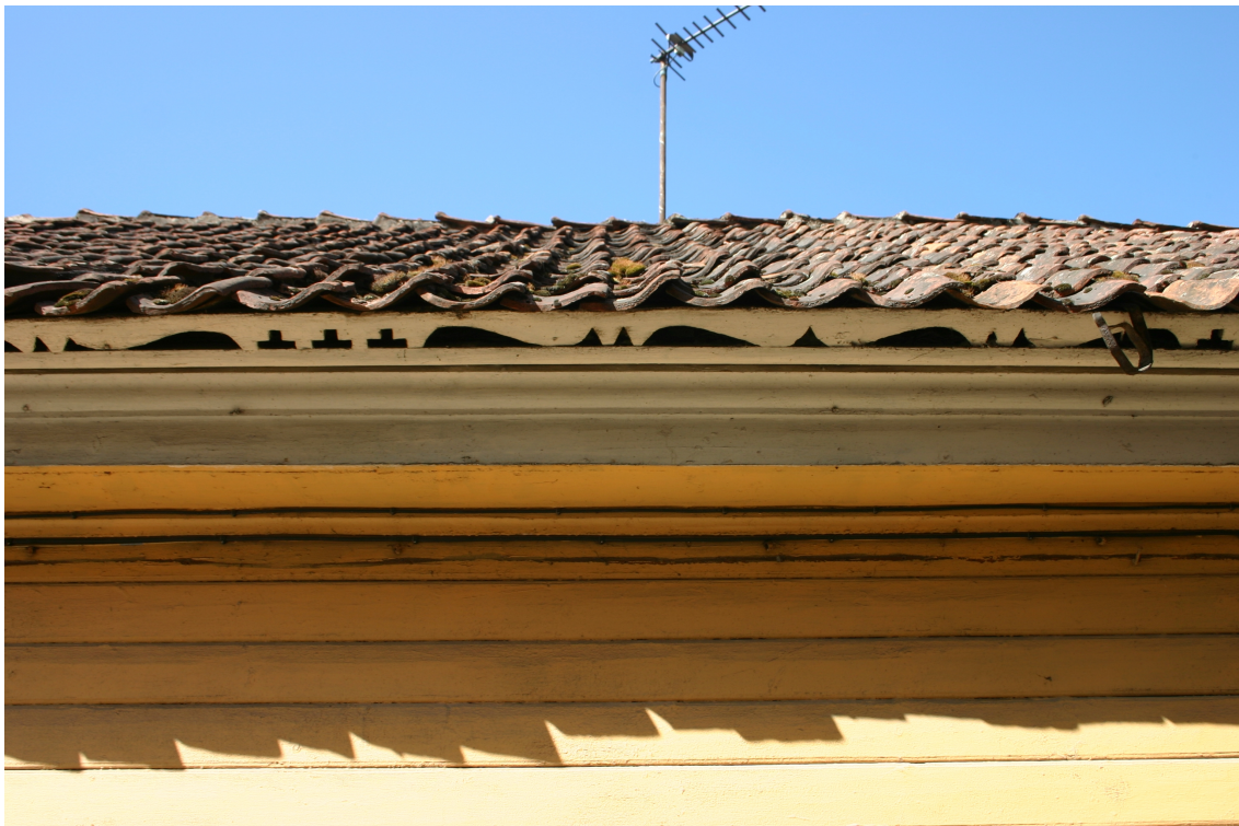
Bazniicas_15_62010060002001_dzega1 20.gs.sāk. dēļu dzega un kokā griezts aizsegdēlis.
