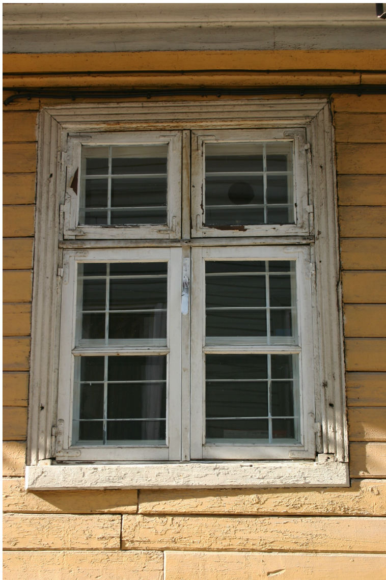
Bazniicas_15_62010060002001_logs1 19.gs.2.puses logs. Vērtnes, iespējams, mainītas 20.gs.2.pusē.
