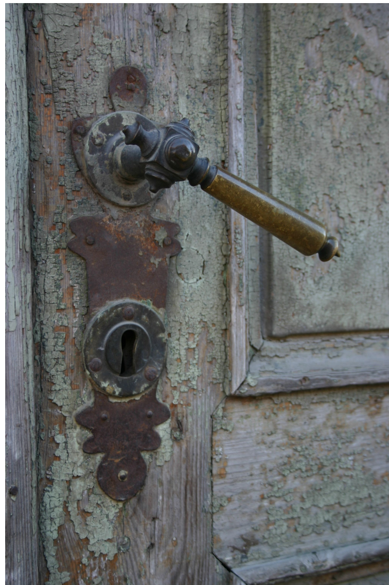
Bazniicas_14_62010060071001_durvis2 19.gs.v.-19.gs.70to gadu sāk. nosegvairodzīņš, kas papildināts ar 19.gs.beigu nosegvairodzīņu un rokturi.
