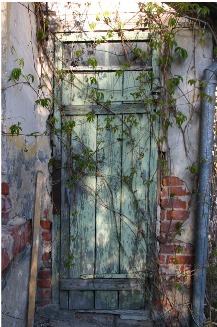
Bazniicas_14_62010060071001_durvis3 Vēsturiskas durvis ar oriģinālo aprīkojumu.
