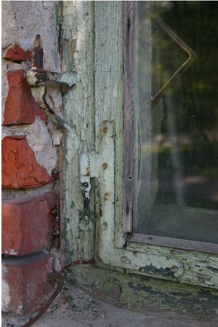
Bazniicas_14_62010060071001_logs2 19.gs.v.-19.gs.70to gadu sāk. loga vira un slēģu viras kāsis.
