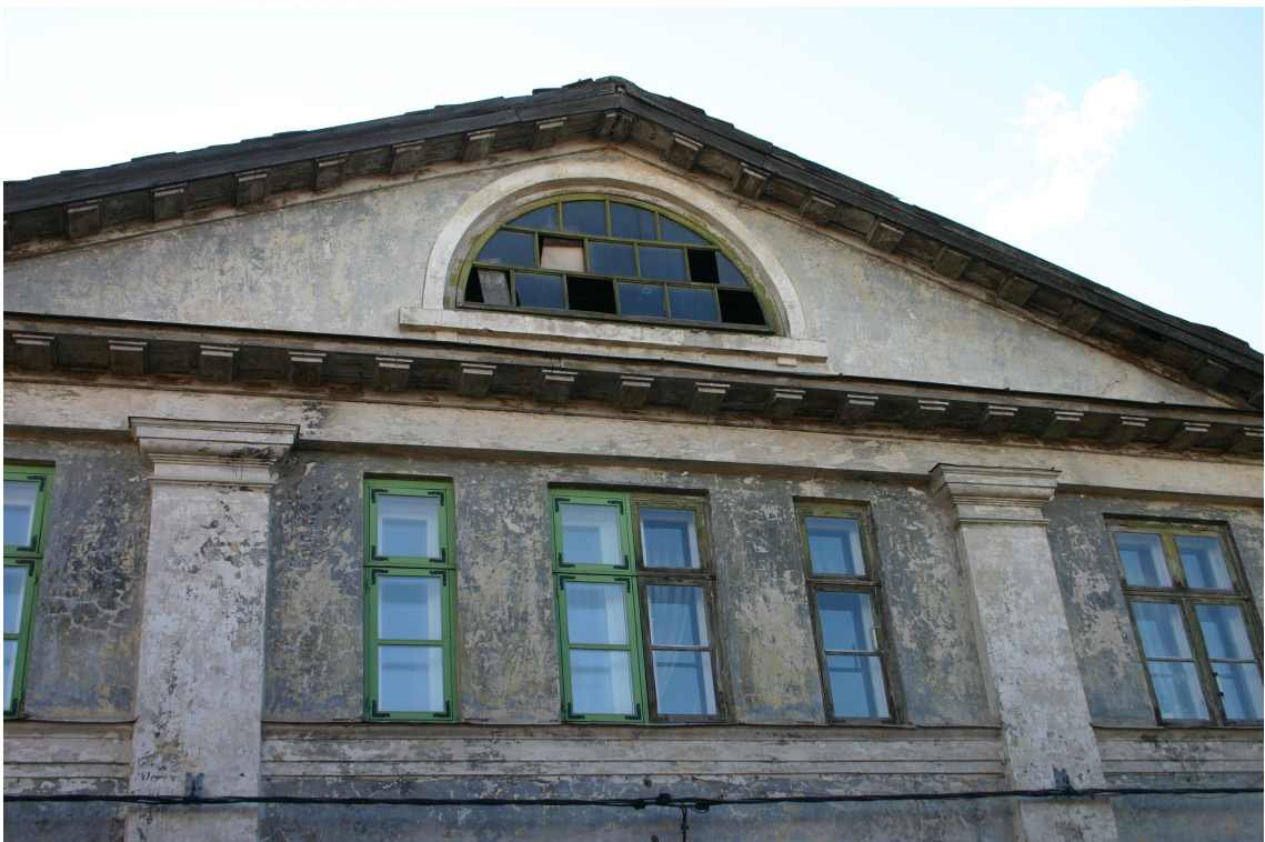
Bazniicas_14_62010060071001_fragments1 Galvenās fasādes centrālās daļas fragments ar 19.gs.v.-19.gs.70to gadu sāk. izveidoto fasāžu apdari un logiem. Izņēmums ir frontona loga vērtne, kas nomainīta 20.gs.2.pusē.
