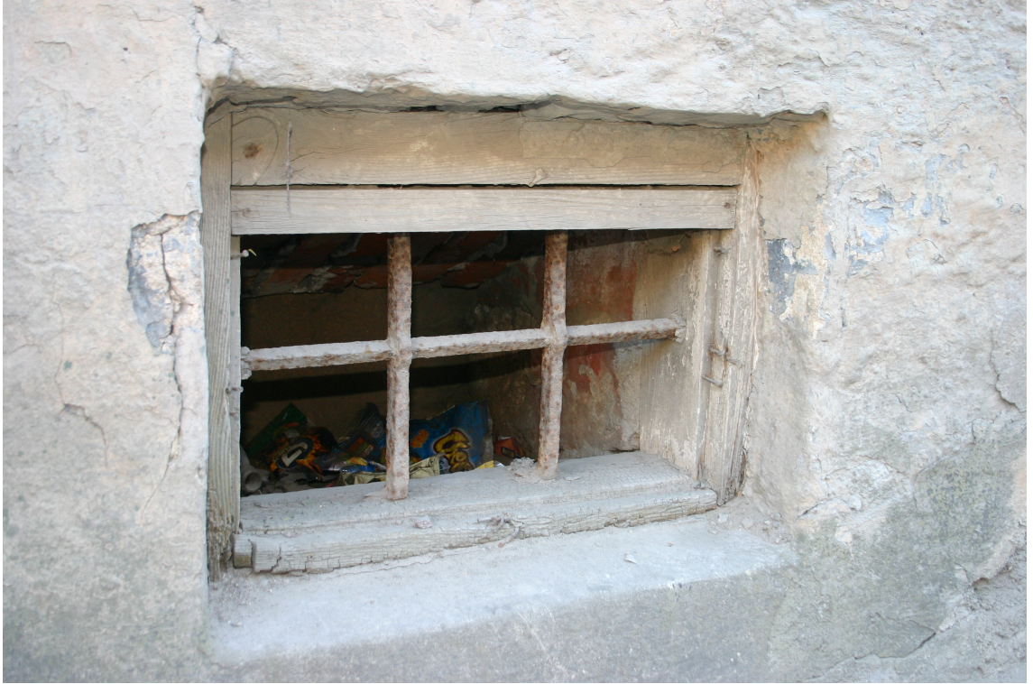
Baznīcas_14_62010060071001_logs4 19.gs.v.-19.gs.70to gadu sāk. loga aploda un metāla restes.
