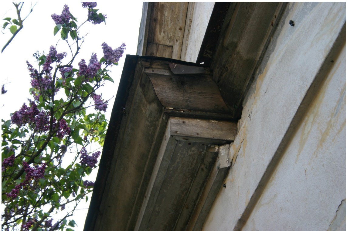
Baznīcas_14_62010060071001_dzega1 Dēļu dzega (19.gs.v.-19.gs.70to gadu sāk.).
