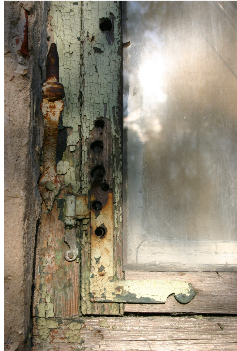
Bazniicas_14_62010060071001_logs3 Atkārtoti izmantota, domājams, 18.gs.beigu loga vira.
