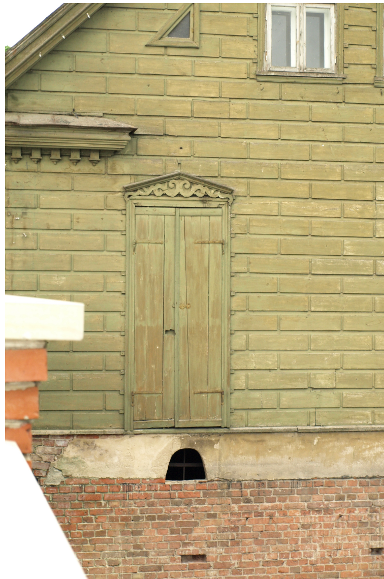
Bazniicas_36_62010220045006_fragments1 Ziemeļaustrumu fasādes fragments ar sākotnējo ...(1870to gadu sāk.-1879.g.) apdari un durvju slēgiem.
