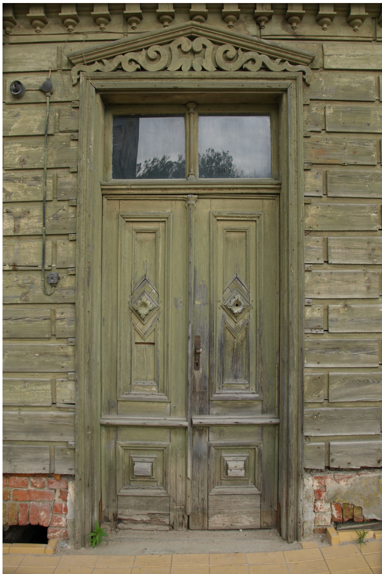
Bazniicas_36_62010220045006_durvis1 Sākotnējs (1870to gadu sāk.-1879.g.) durvju komplekts.
