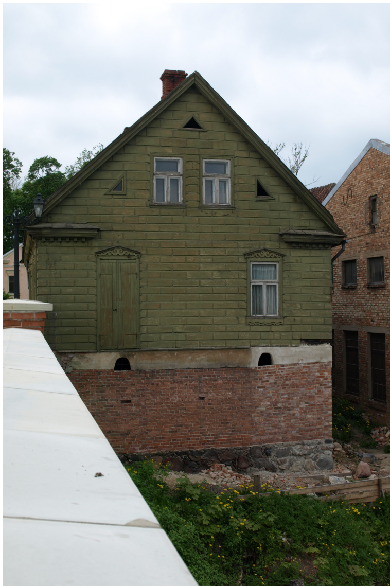
Bazniicas_36_62010220045006_fasade3 Skats uz ēkas ziemeļaustrumu fasādi.
