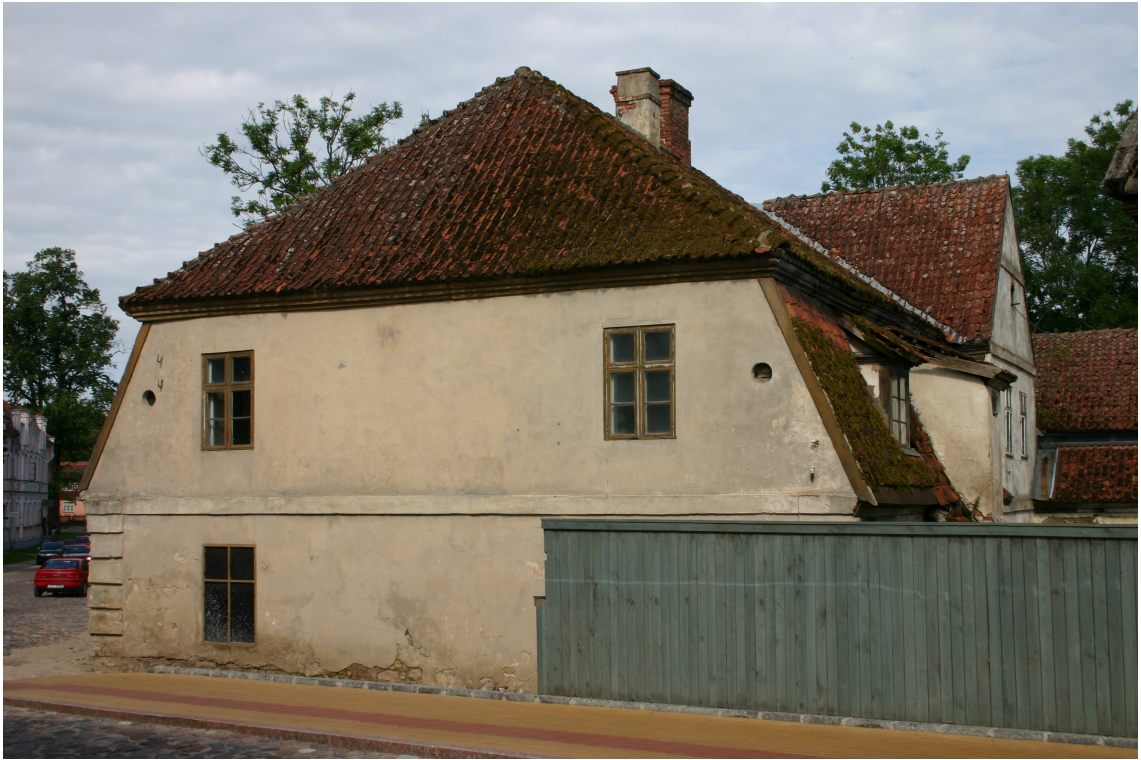
Bazniicas_36_62010220045001_fasade3 Skats uz ēku no austrumiem.
