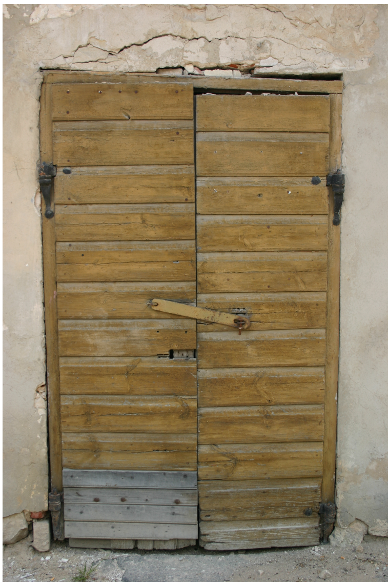
Bazniicas_36_62010220045001_durvis1 Vēsturiskas durvis ar oriģinālo aprīkojumu.
