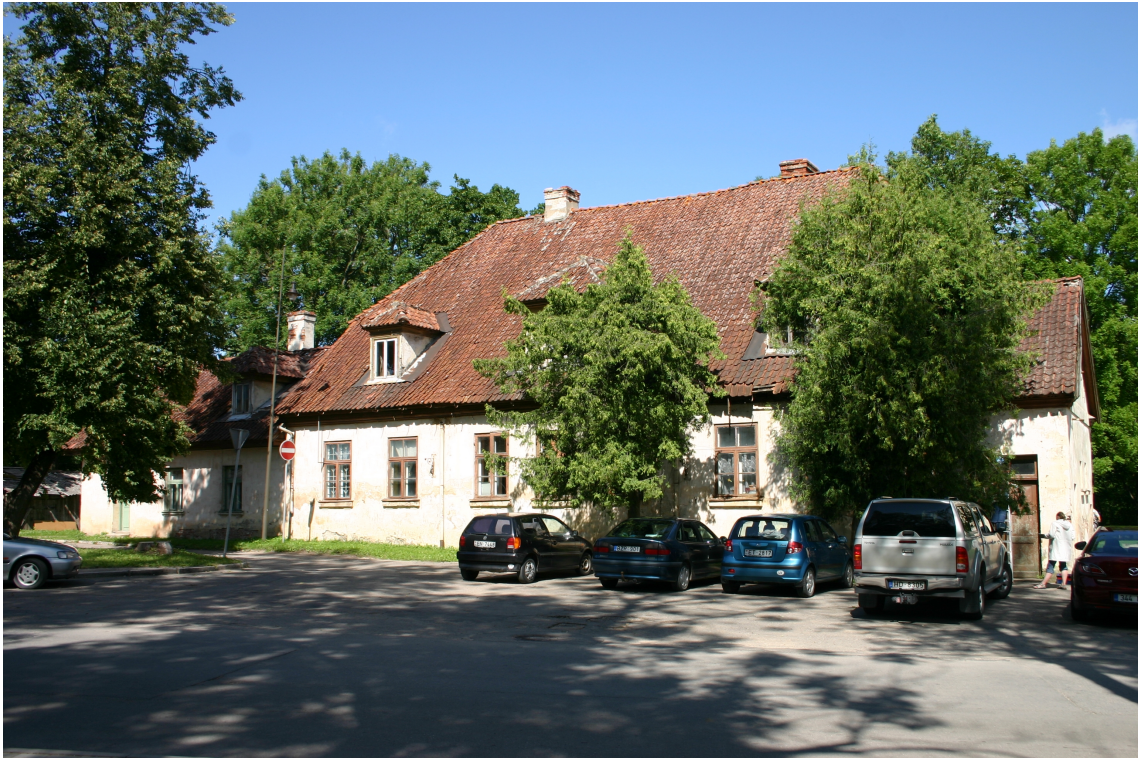
Bazniicas_34_62010060074001_fasade1 Skats uz ēku no dienvidrietumiem.
