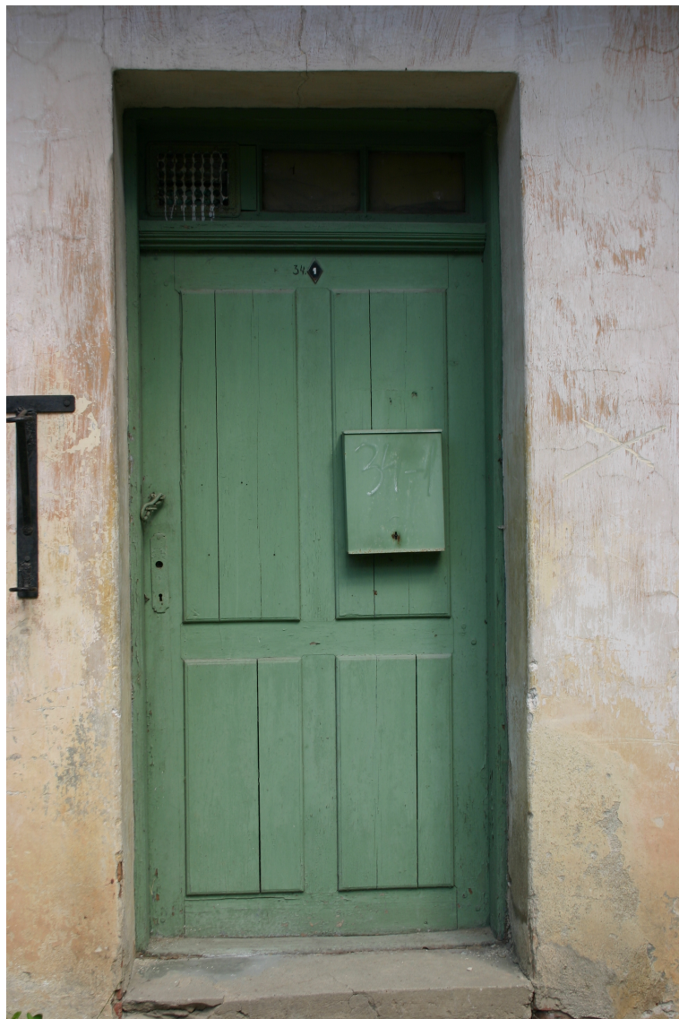
Baznīcas_34_62010060074001_durvis3 20.gs.1.cet. (pēc 1913.g.) durvju komplekts ar daļēji saglabājušos aprīkojumu.
