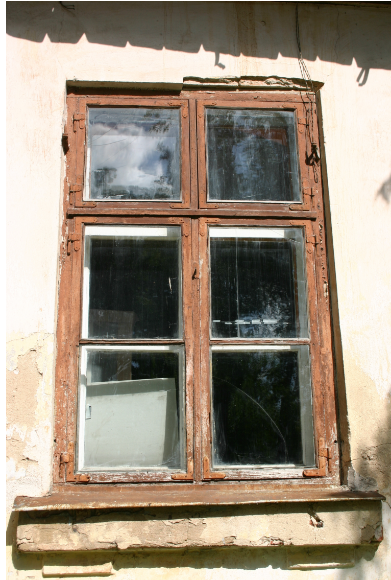
Baznīcas_34_62010060074001_logs3 20.gs.1.cet. (pēc 1913.g.) logs ar oriģinālo aprīkojumu.
