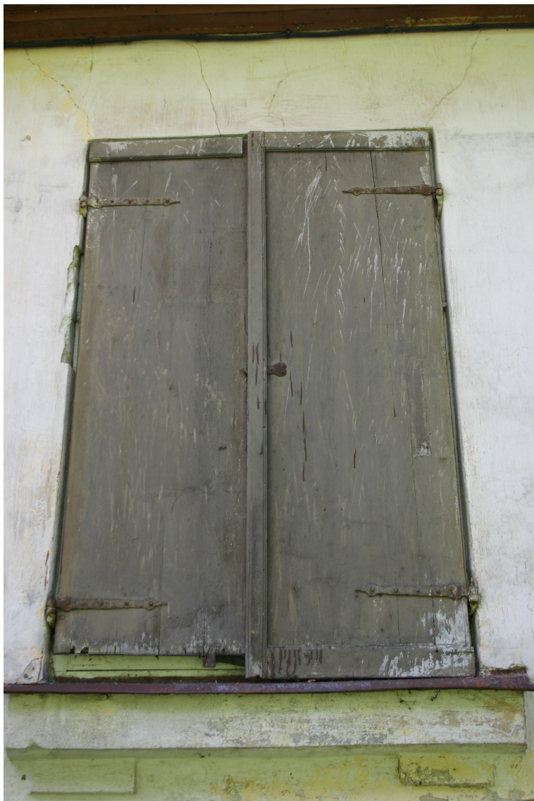
Baznīcas_34_62010060074001_slegis1 19.gs.3.cet. slēģi ar oriģinālo aprīkojumu.
