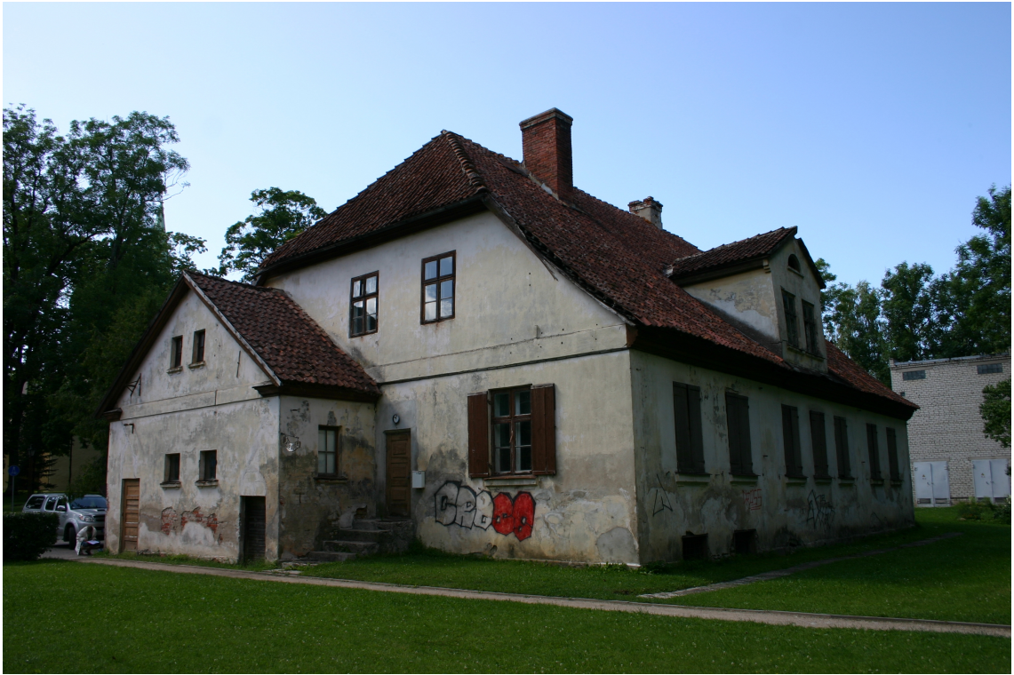
Bazniicas_34_62010060074001_fasade3 Skats uz ēku no austrumiem.
