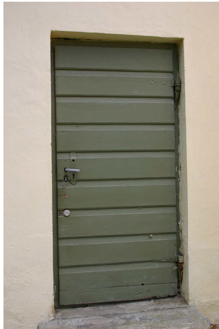
Baznīcas_33_62010060031001_durvis6 Vēsturiskas durvis ar daļēji saglabājušos aprīkojumu.
