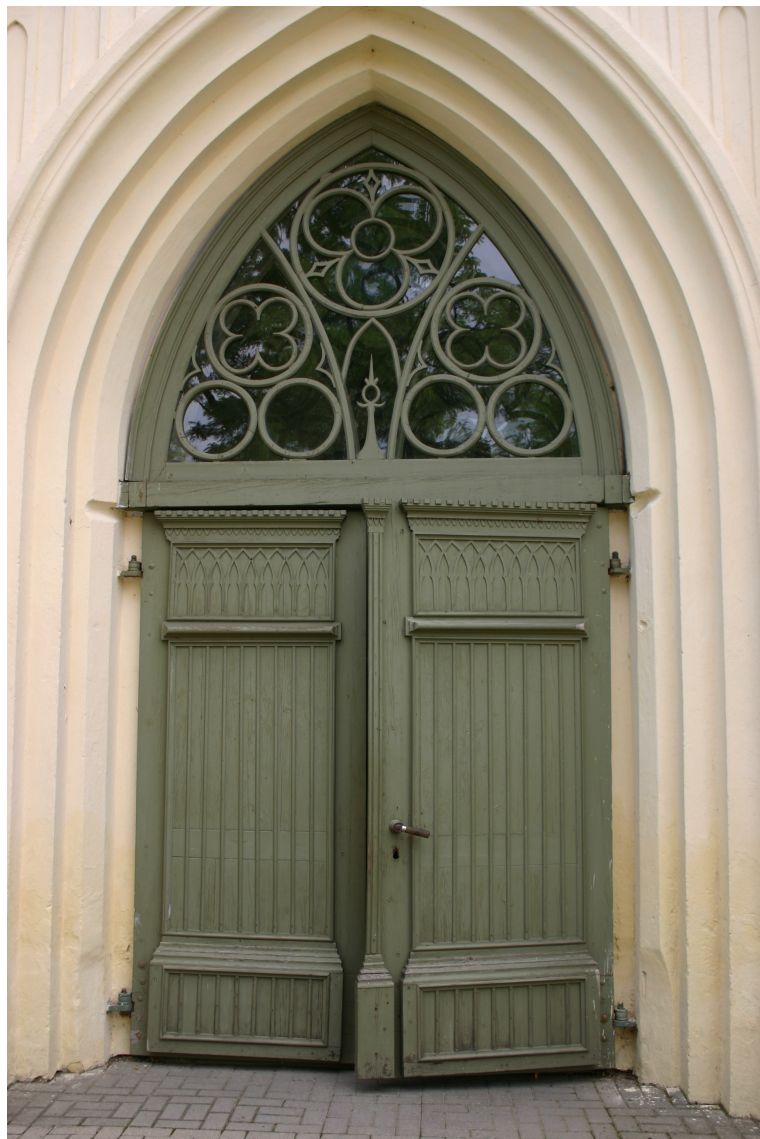
Baznīcas_33_62010060031001_durvis3 Vēsturiskas (remontētas) durvis ar oriģinālo aprīkojumu.
