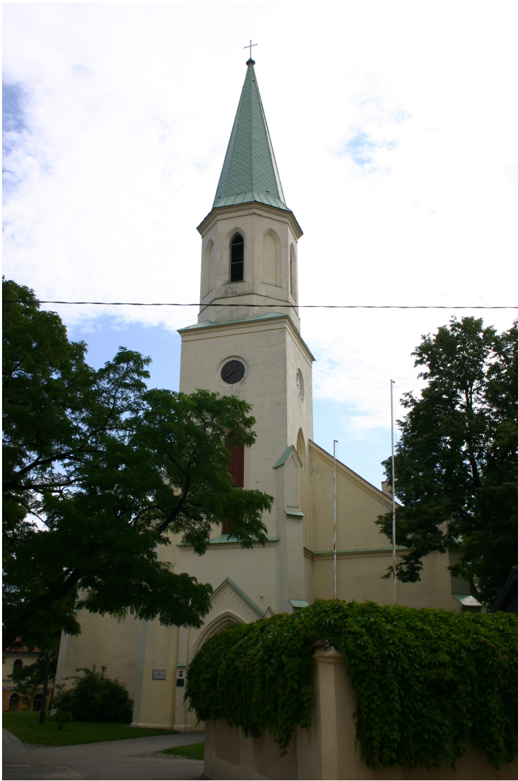
Baznīcas_33_62010060031001_fasade1 Skats uz ēku no dienvidrietumiem.
