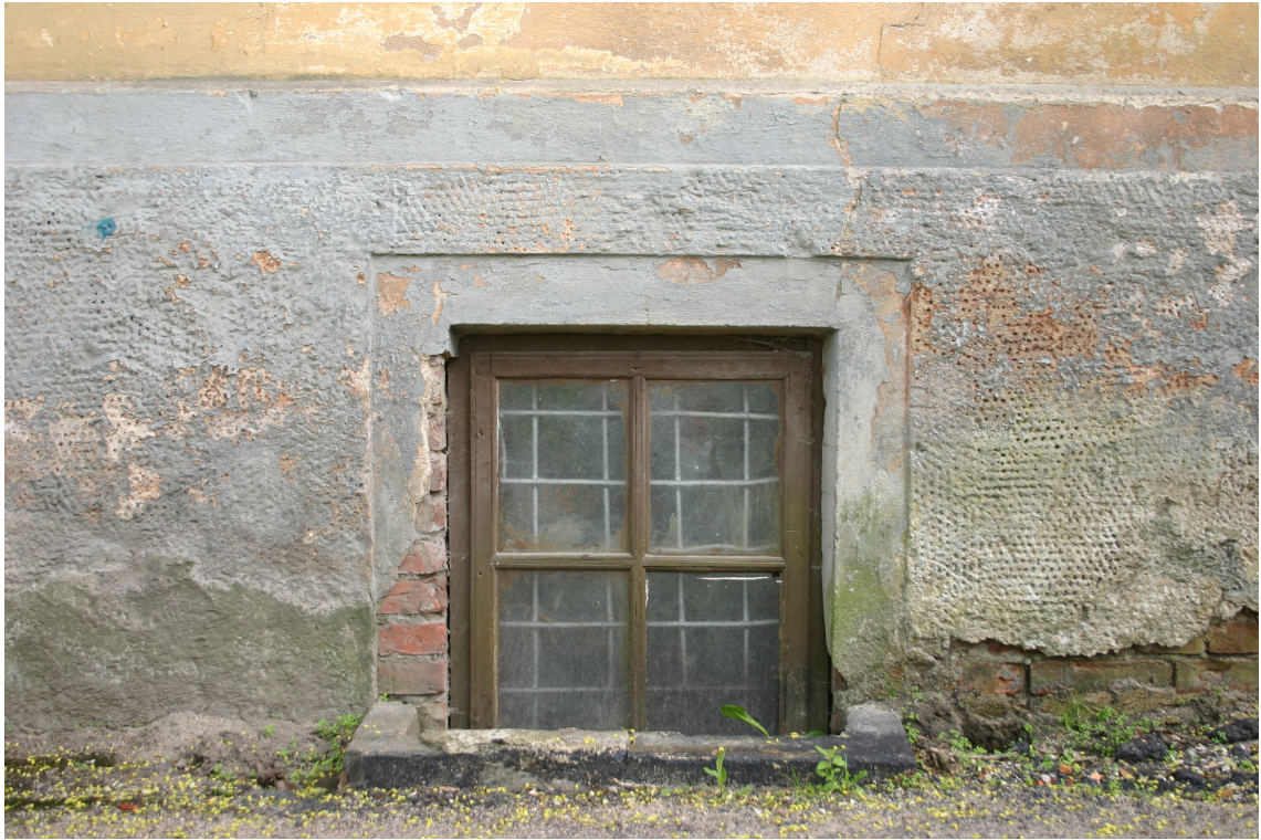
Bazniicas_32_62010060008001_fragments2 Ziemeļrietumu fasādes fragments ar sākotnējo (19.gs.b.) apmetuma apdari.
