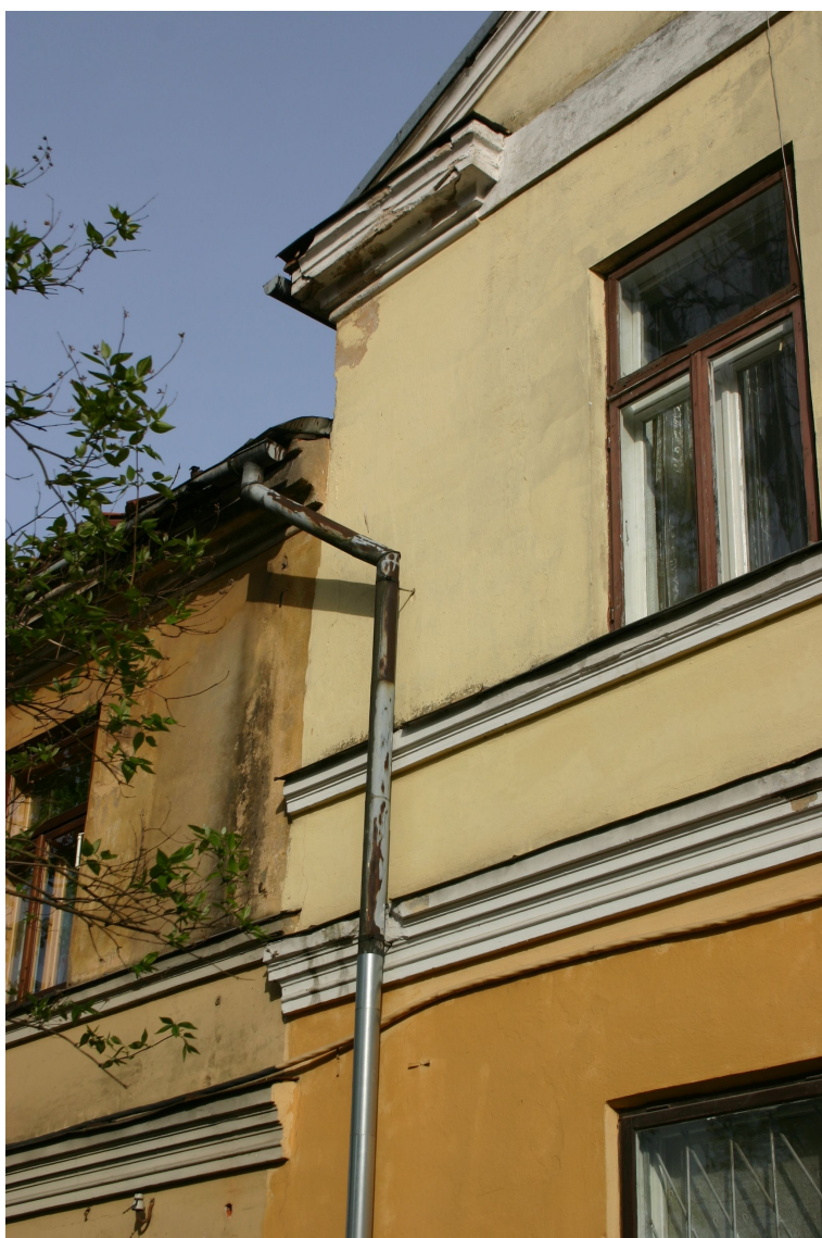
Baznīcas_32_62010060008001_fragments1 Ziemeļrietumu fasādes fragments ar sākotnējām (19.gs.b.) dzegām un starpdzegām.
