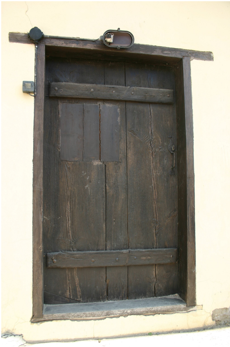
Baznīcas_31_62010060032001_durvis4 Vēsturiskas durvis ar oriģinālo aprīkojumu.
