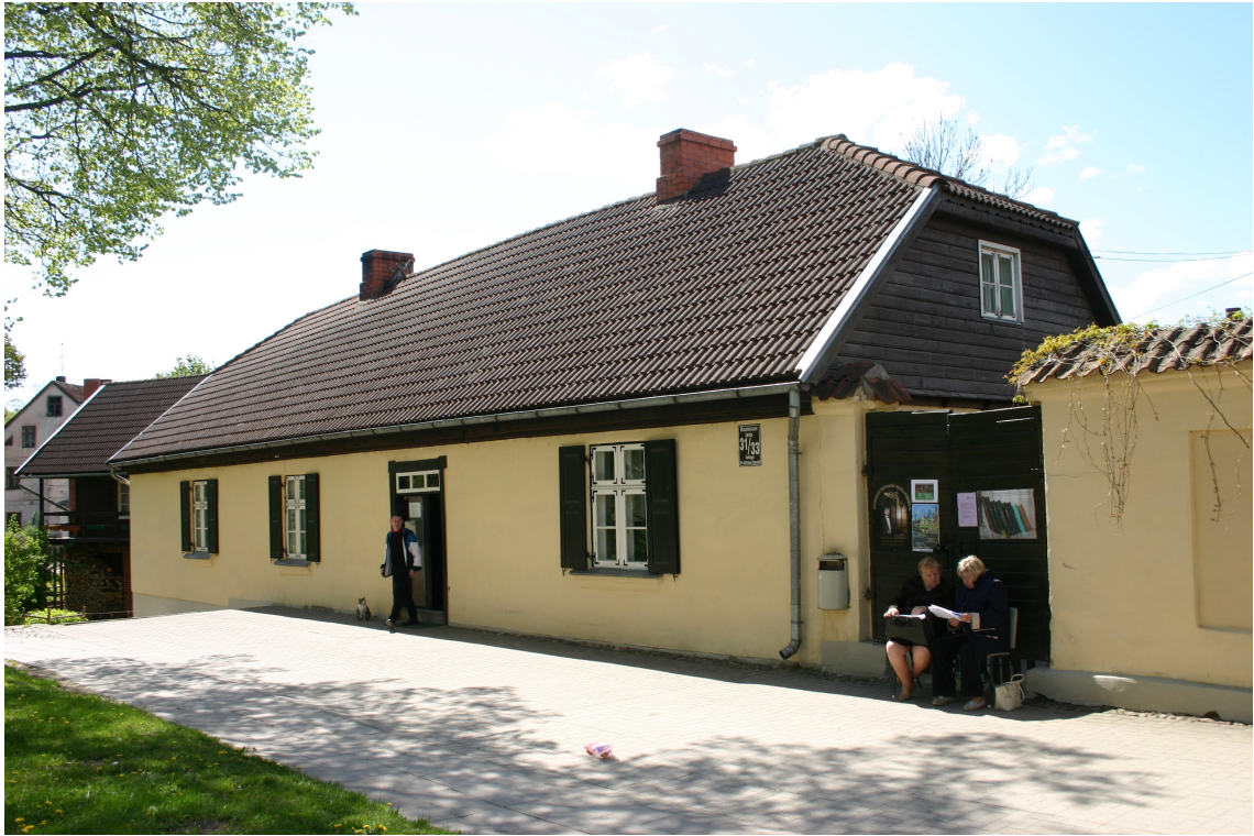
Bazniicas_31_62010060032001_fasade1 Skats uz ēku no ziemeļiem.
