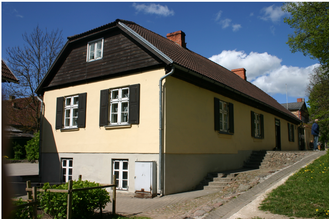
Bazniicas_31_62010060032001_fasade2 Skats uz ēku no austrumiem.
