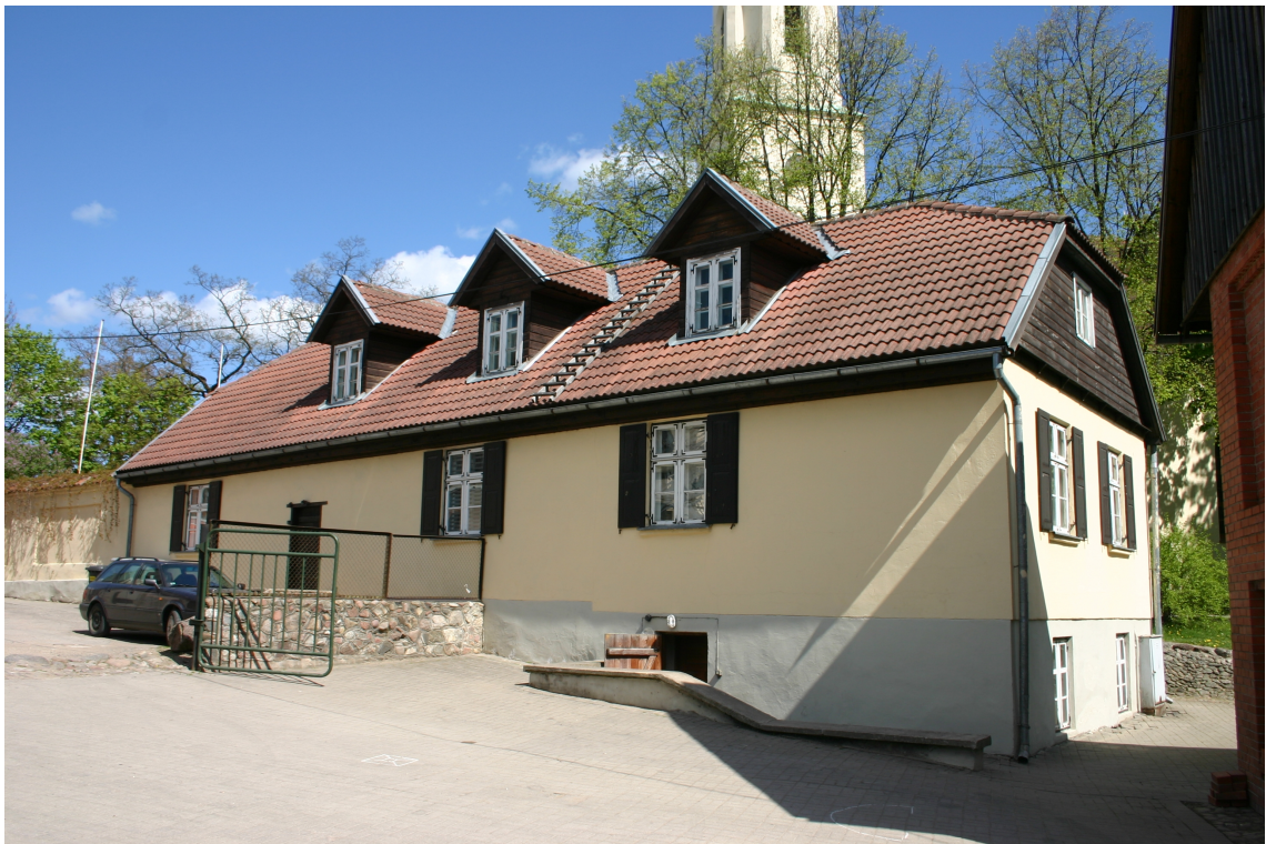
Baznīcas_31_62010060032001_fasade3 Skats uz ēku no dienvidiem.
