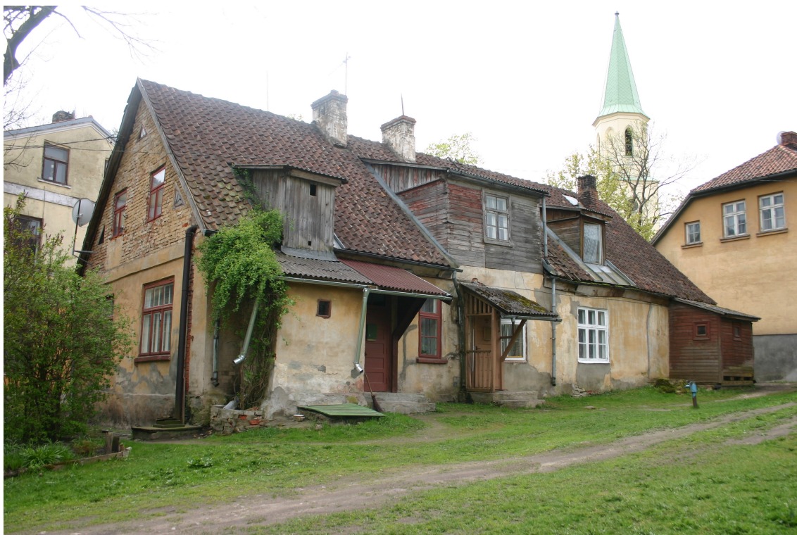
Baznīcas_30_62010060007001_fasade2 Skats uz ēku no ziemeļaustrumiem. Tuvākā piebūve datējama ar laiku no 1913.-20.gs.20.,30.g., tālākā – 20.gs.2.puse. Mezonīns ir vēsturisks, jumta izbūves – 20.gs.2.puse.
