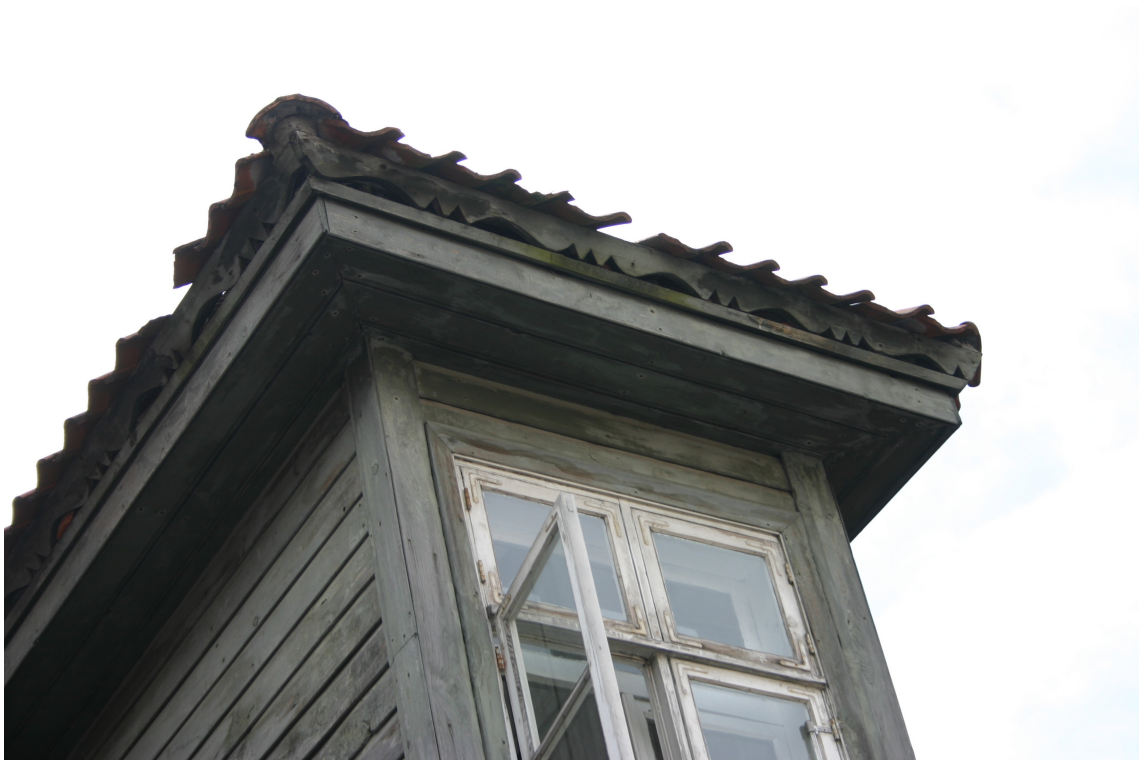
Bazniicas_28_62010060023001_fragments1 Jumta izbūve ziemeļu fasādē (20.gs.2.puse).
