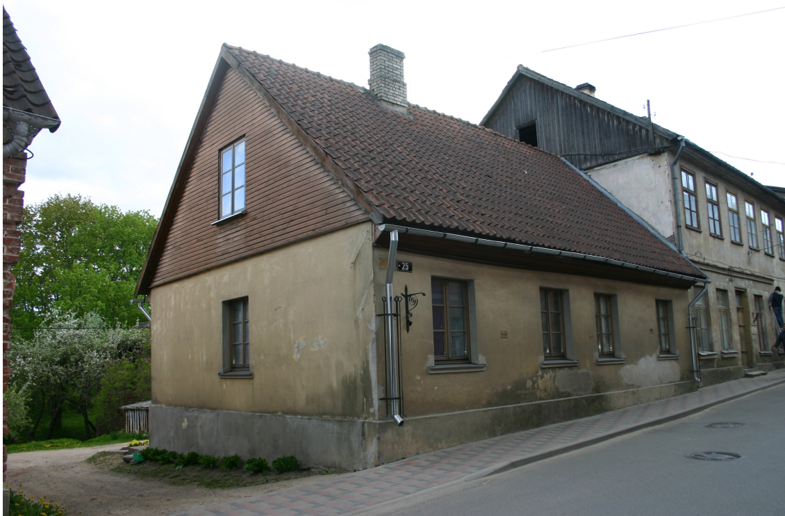
Baznīcas_25a_62010060026001_fasade1 Skats uz ēku no ziemeļiem.
