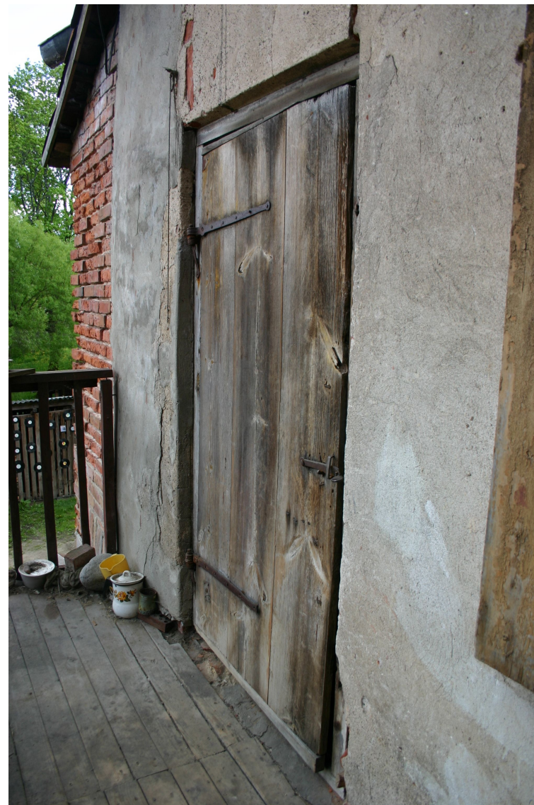
Bazniicas_23_62010060073001_durvis2 Sākotnējās (1870to gadu sāk. - 1879.g.) durvis ar oriģinālo aprīkojumu.
