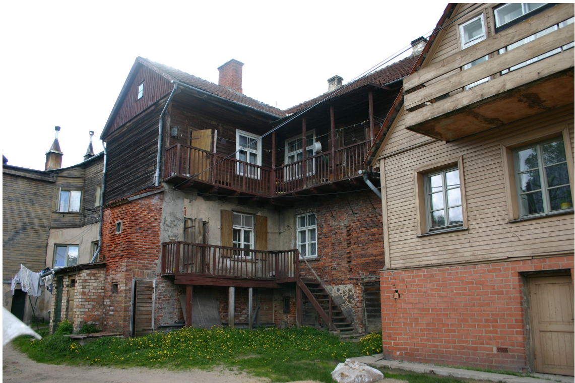
Baznīcas_23_62010060073001_fasade2 Skats uz ēku no austrumiem. Esošās koka galerijas izveidotas 20.gs.2.pusē.
