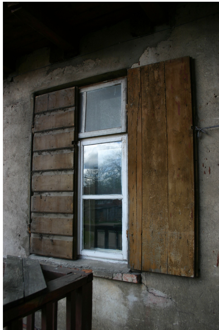
Baznīcas_23_62010060073001_slegi1 Sākotnēji (1870to gadu sāk. - 1879.g.) slēģi ar oriģinālo aprikojumu.
