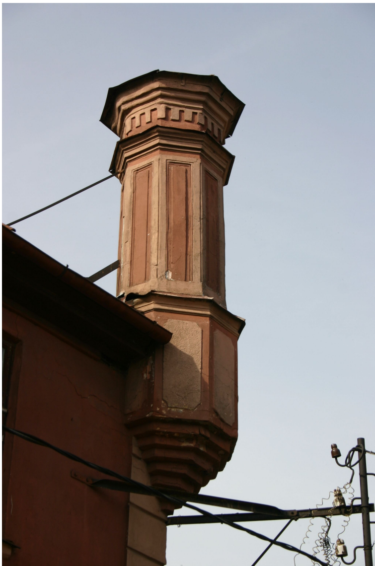
Baznīcas_22_62010060067001_fragments2 19.gs.pēd.cet. izveidotais tornītis Policijas un Baznīcas ielu stūrī.
