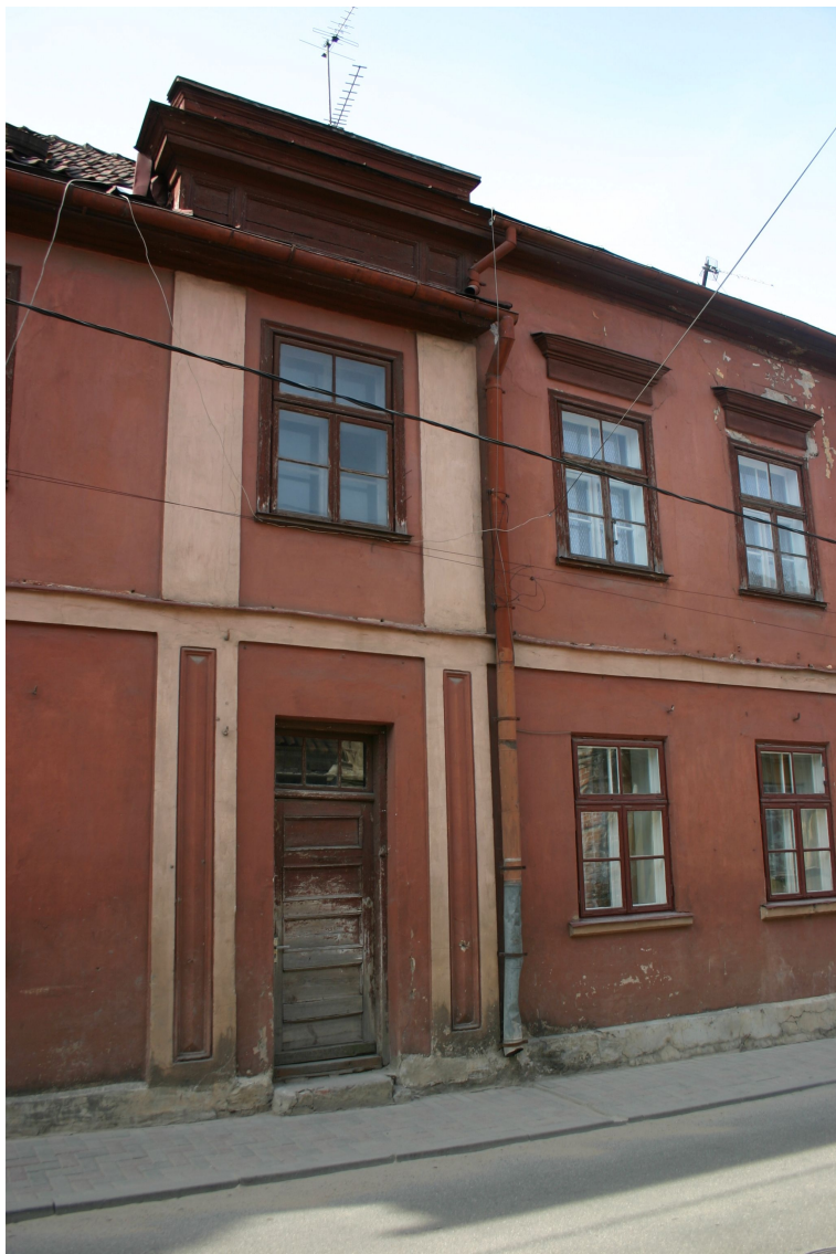
Baznīcas_22_62010060067001_fragments1 Baznīcas ielas korpusa fasādes fragments. Esošā fasāžu apdare izveidota 19.gs.pēd.cet.
