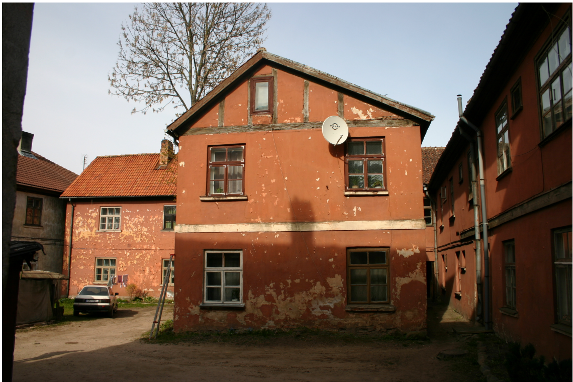
Baznīcas_22_62010060067001_fasade5 Skats uz ēku no dienvidrietumiem. Centrā redzams 1797.-1813.g. pagalma korpuss, kam vēlāk uzbūvēts 2.stāvs.
