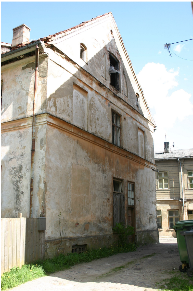
Bazniicas_20_62010060066001_fasade3 Skats uz ēkas dienvidrietumu fasādi.
