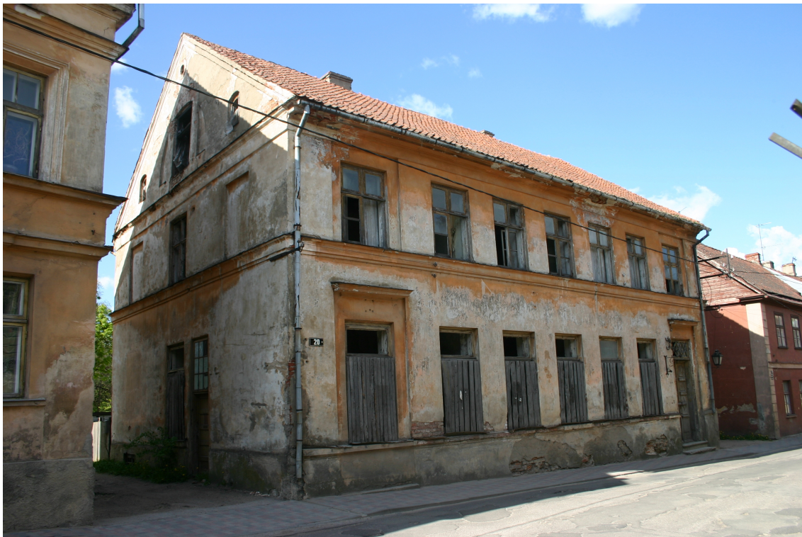
Baznīcas_20_62010060066001_fasade1 Skats uz ēku no dienvidiem.
