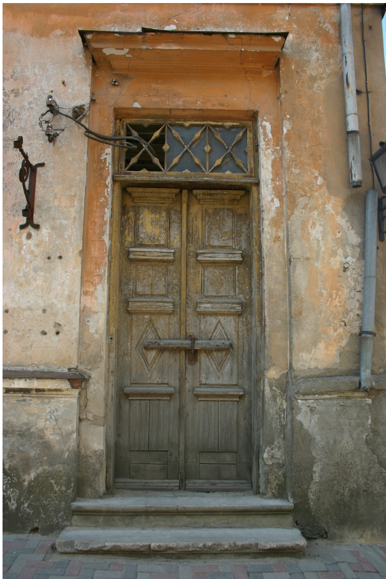
Bazniicas_20_62010060066001_durvis1 Sākotnējs (19.gs.3.cet.) durvju komplekts (iespējams, izmantotas vecākas vārtnes, kas pārveidotas)
