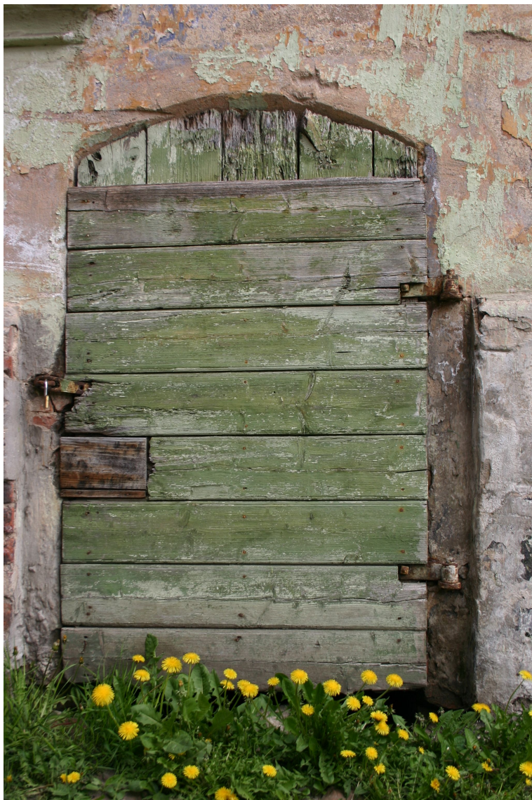
Baznīcas_19_62010060072001_durvis2 Sākotnējas (19.gs.pēd.cet., pēc 1879.g.) durvis ar oriģinālo aprīkojumu.
