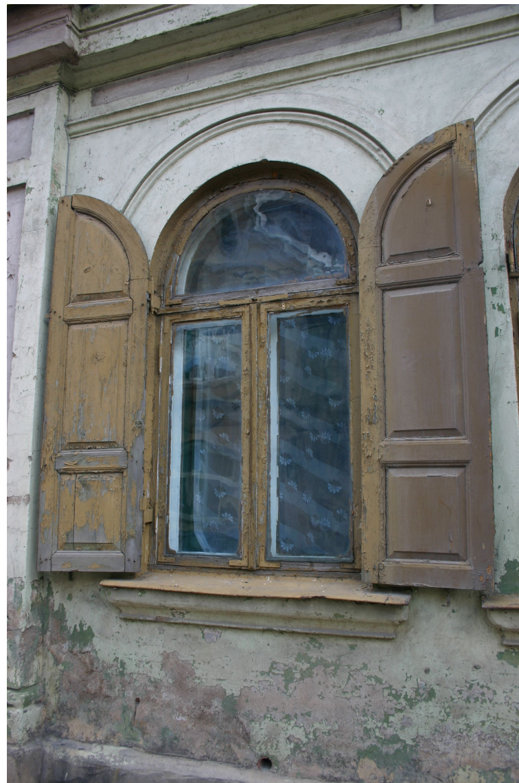
Baznīcas_19_62010060072001_logs1 Sākotnējs (19.gs.pēd.cet., pēc 1879.g.) logs un slēgi ar oriģinālo aprīkojumu ielas fasādē.
