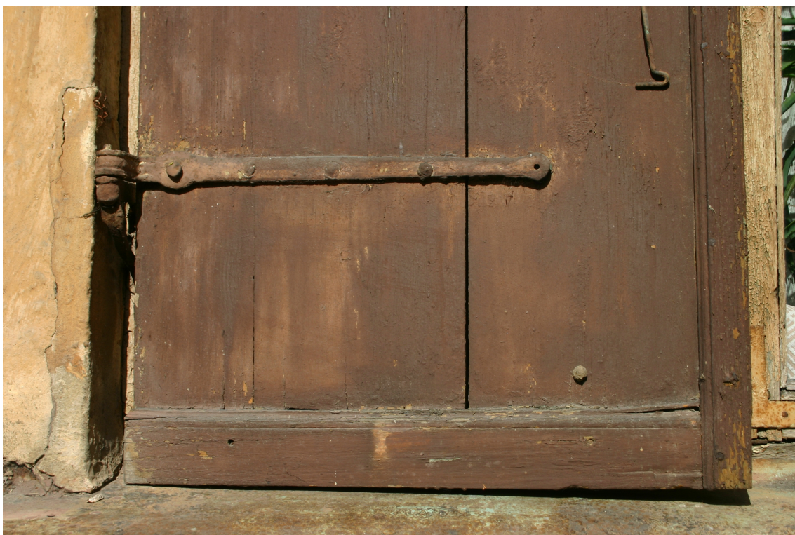
Bazniicas_19_62010060072001_detala2 Sākotnēja (19.gs.pēd.cet., pēc 1879.g.) slēga vira pagalma fasādē.
