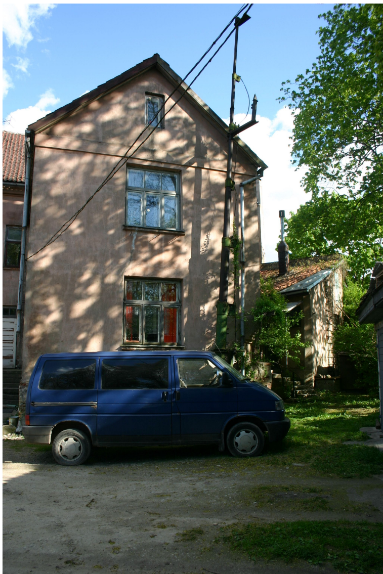
Baznīcas_18_62010060065001_fasade4 Sākotnējās (19.gs.3.cet.) piebūves ziemeļrietumu fasāde.
