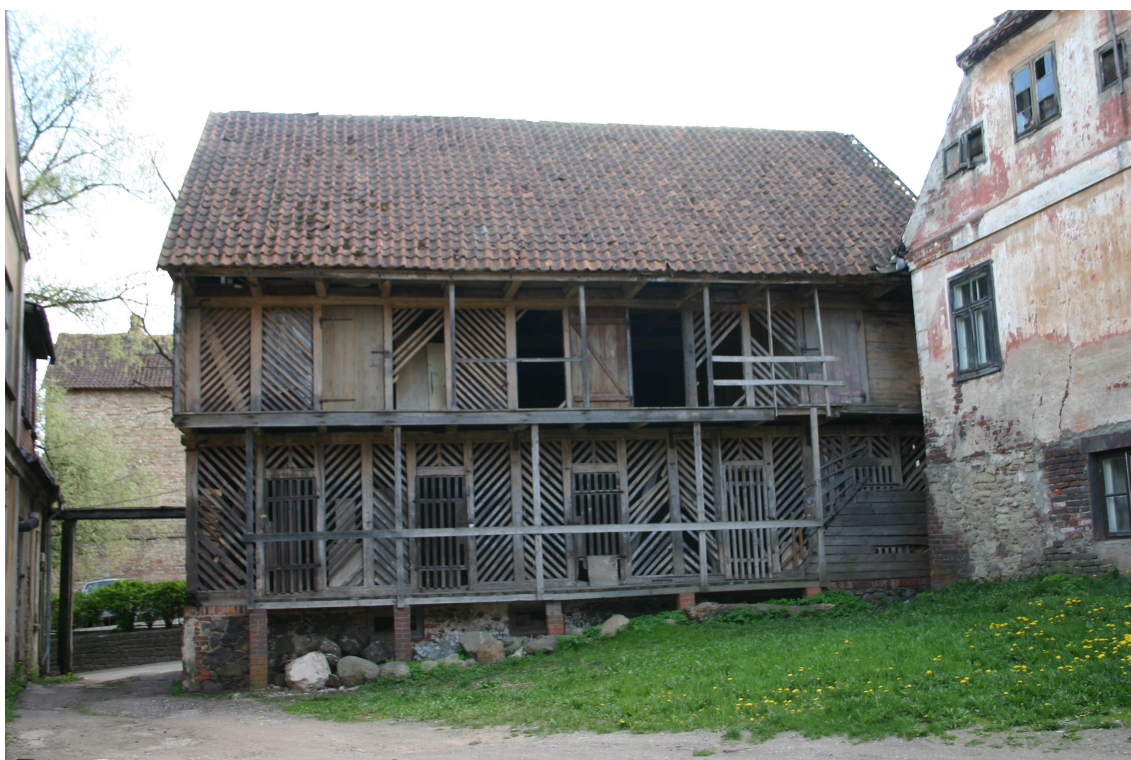
Baznīcas_17_62010060058002_fasade1 Skats uz ēkas ziemeļu fasādi.
