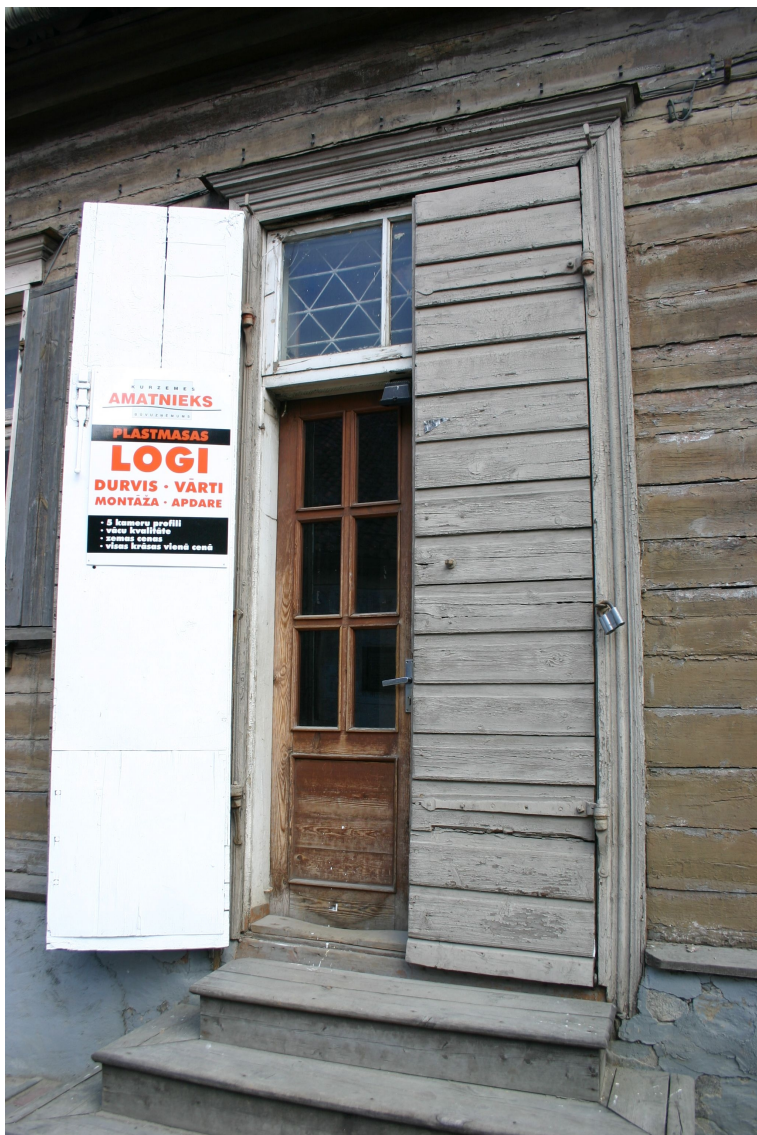
Bazniicas_17_62010060058001_slegi1 19.gs.beigu durvju slēgi ar oriģinãlo aprikojumu.
