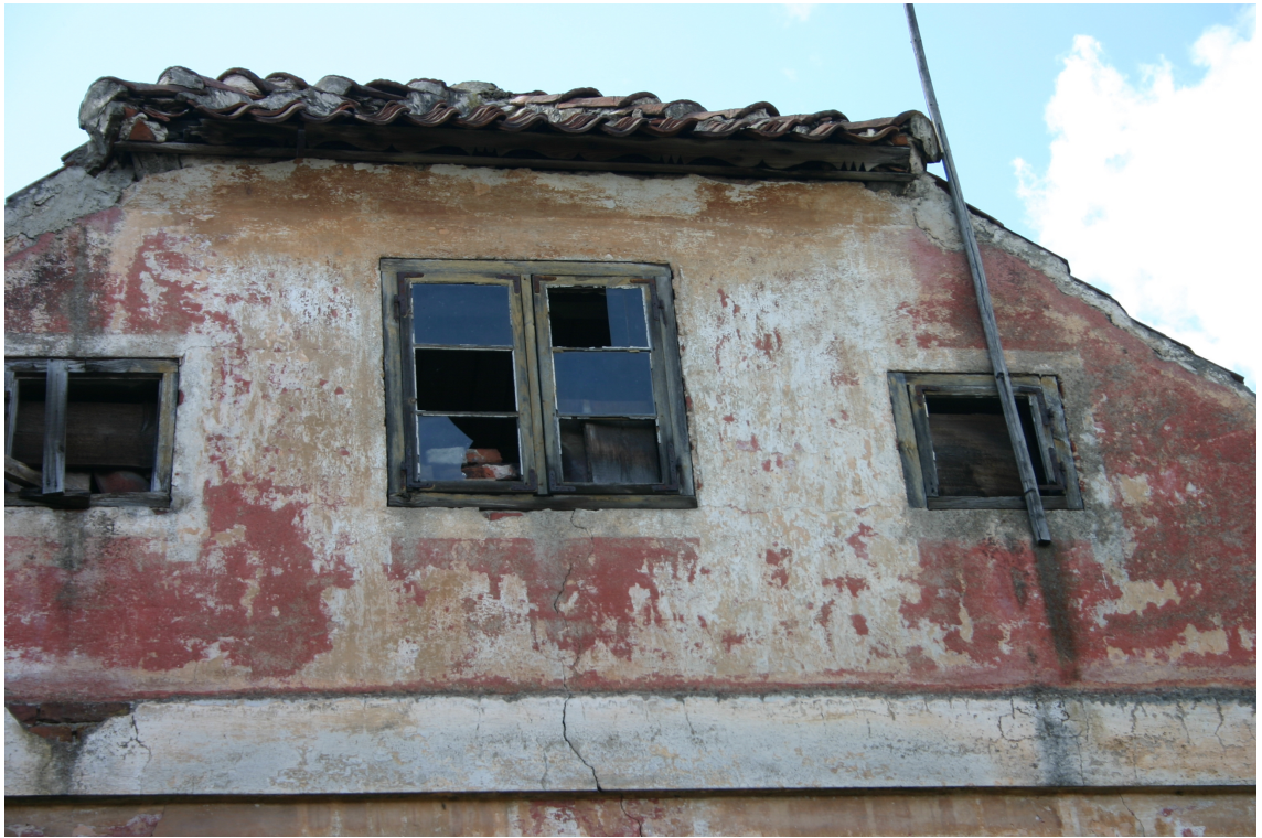
Bazniicas_17_62010060058001_fragments1 19.gs.2.cet. piebūves fragments ar oriģinālajiem logiem un fasādes krāsojumu.
