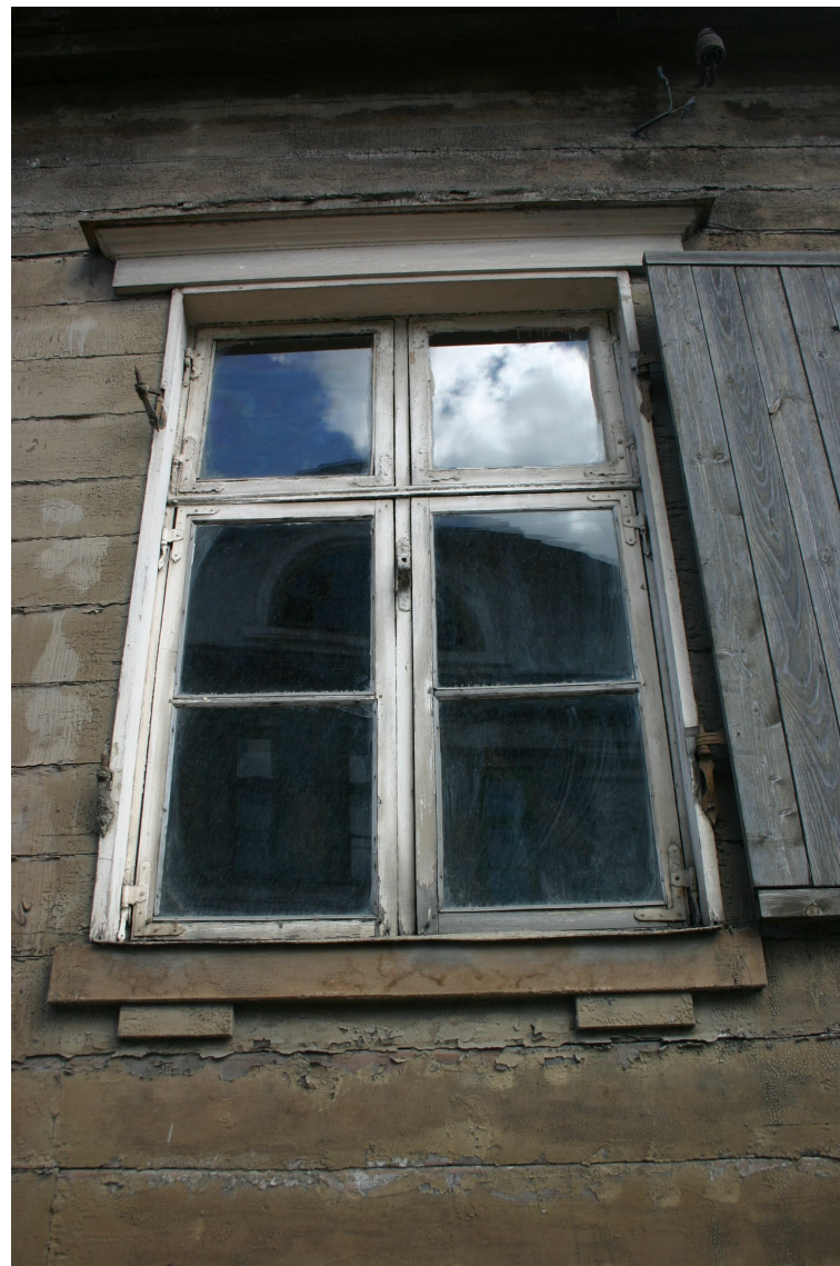
Baznīcas_17_62010060058001_logs1 19.gs.2.cet. logs. Augšējām vērtņēm atkārtoti izmantots 18.gs.3.cet. aprīkojums. Apakšējās vērtnes un to aprīkojums – 20.gs.sāk.
