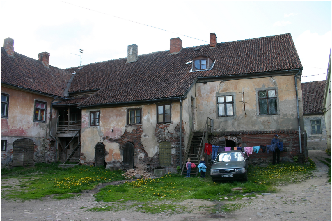
Bazniīcas_17_62010060058001_fasade3 Skats uz ēku no austrumiem.
