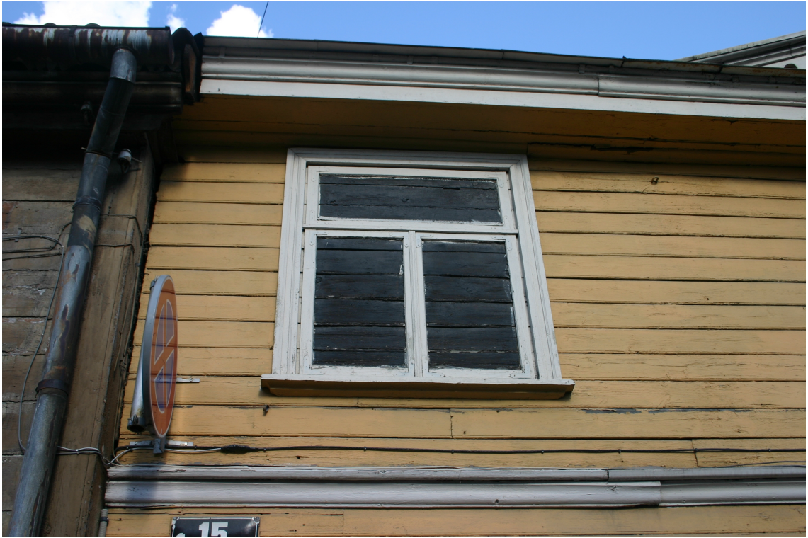
Baznīcas_15_62010060002001_fragments1 20.gs.sāk. izveidotās dzegas, fasāžu apdare un "aklais" logs.
