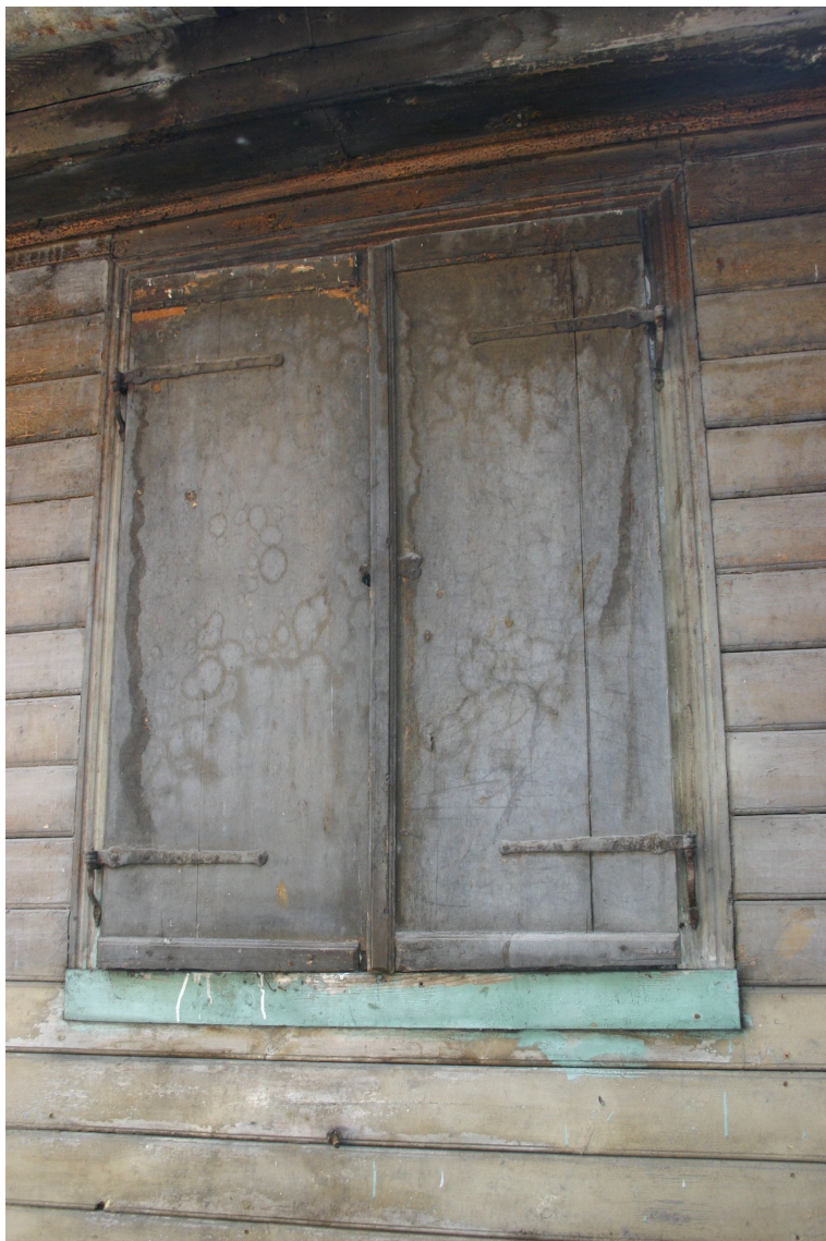
Baznīcas_15_62010060002001_slegi1 Domājams, 19.gs.3.cet. Slēģi ar oriģinālo aprīkojumu.
