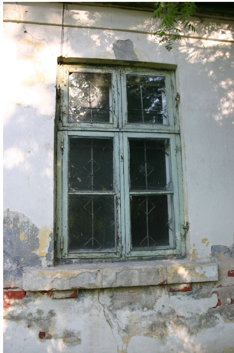
Bazniicas_14_62010060071001_logs1 19.gs.v.-19.gs.70to gadu sāk. logs. Apakšējās vērtnes nomainītas 20.gs.2.pusē. Augšējām vērtņēm oriģinālais aprīkojums.
