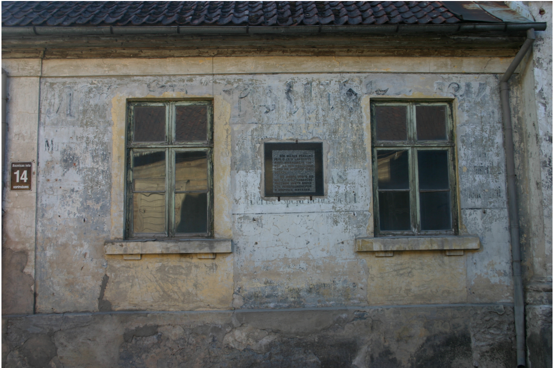
Baznīcas_14_62010060071001_fragment2 Esošās logailas un logi izveidoti 20.gs.2.pusē, kad likvidēts skatlogs un durvis. Uz fasādes redzamas 20.gs.1.puses reklāmas.
