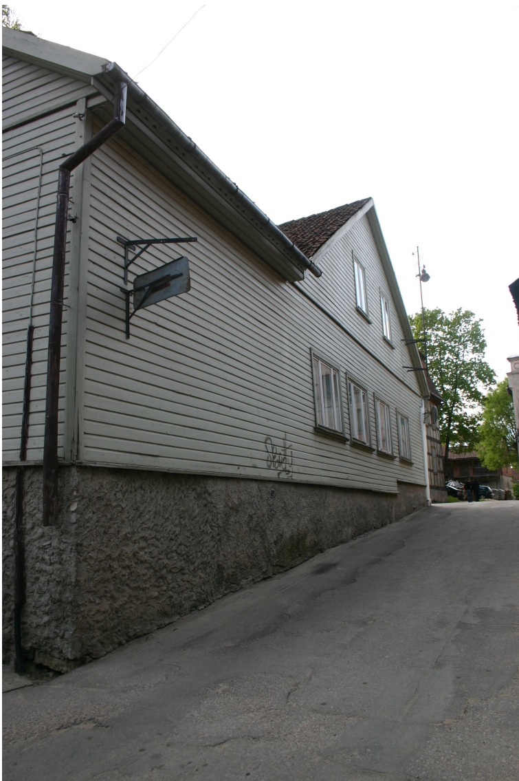
Baznīcas_13_62010060001001_fasade2 Skats uz ēkas ziemeļu fasādi.
