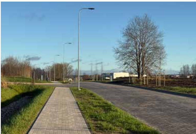
Kuldīgā tagad var ērti izbraukt pa Zirņu un Rudzu ielu. Tās ir izbūvētas, lai pilsētas dienvidos nodrošinātu labāku infrastruktūru un atbalstītu jaunu uzņēmumu darbību.
