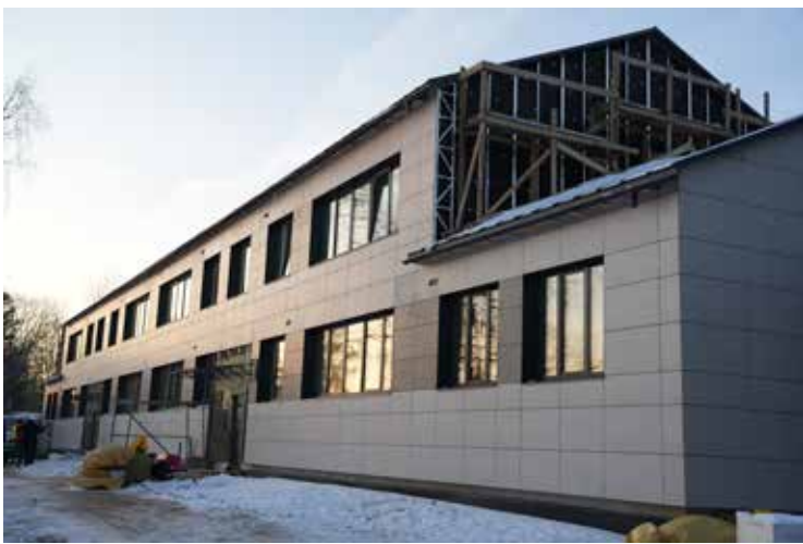
Turpinās darbi Vakara ielā 6 (Kuldīgā), lai ēku pārbūvētu par dzīvojamo māju ar 14 dažāda izmēra dzīvokļiem.
