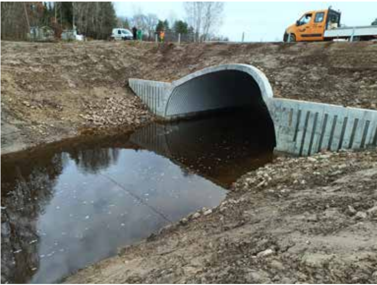
Lai saglabātu un uzlabotu zivju dzīvotnes un nārsta iespējas, Riežupē pabeigta caurtekas pārbūve.
