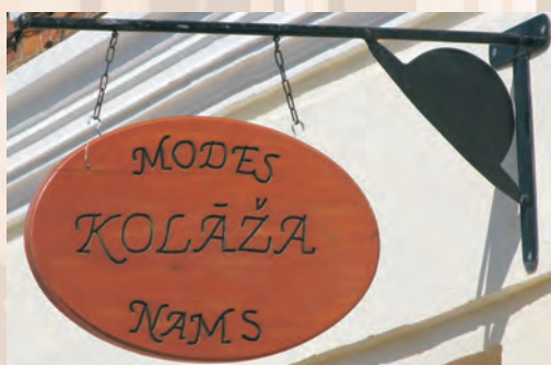
KALTA METĀLA KONSTRUKCIJA, FRĒZĒTA, KRĀSOTA KOKA VIRSMA
