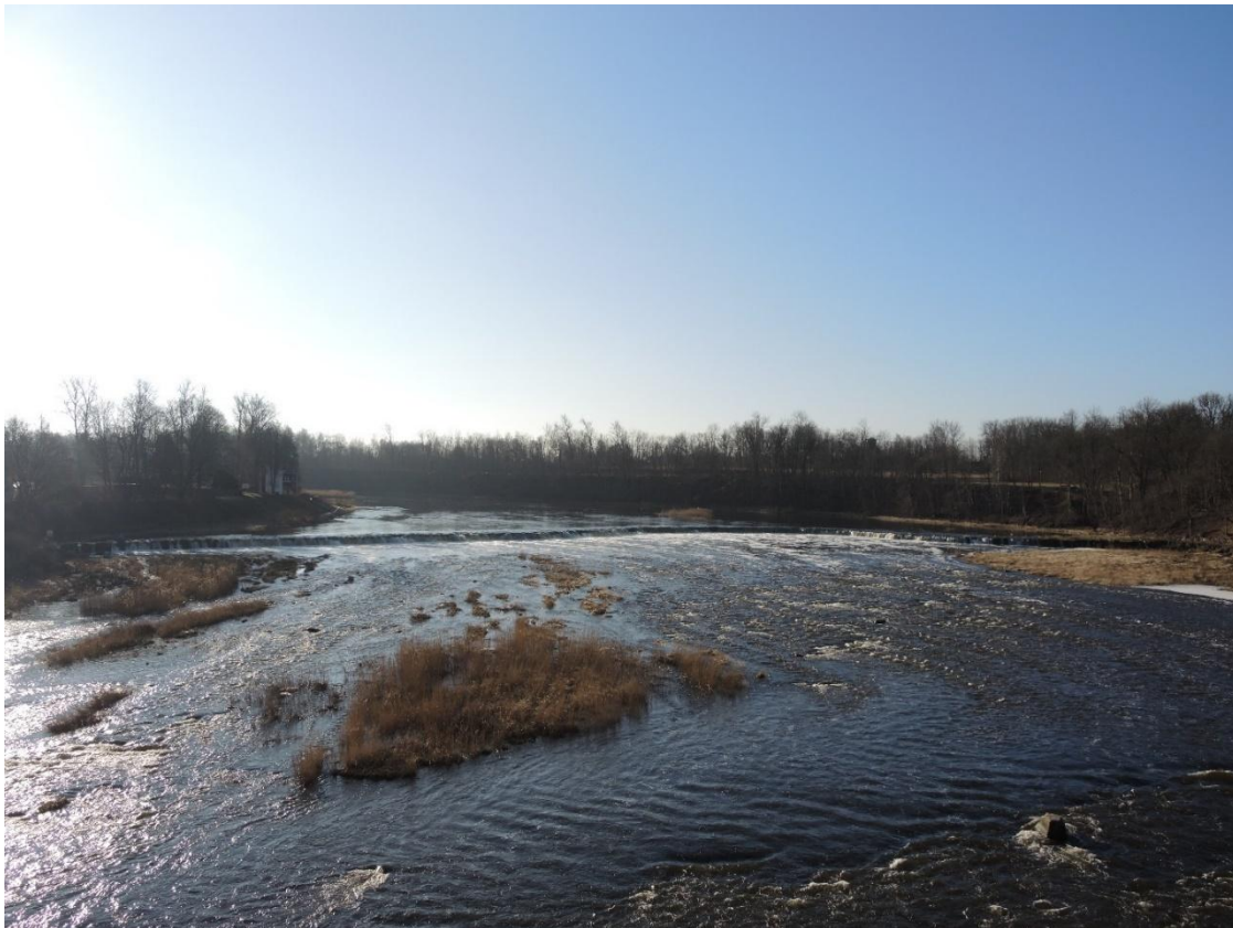
10. attēls: Skats no ķieģeļu tilta dienvidu virzienā
