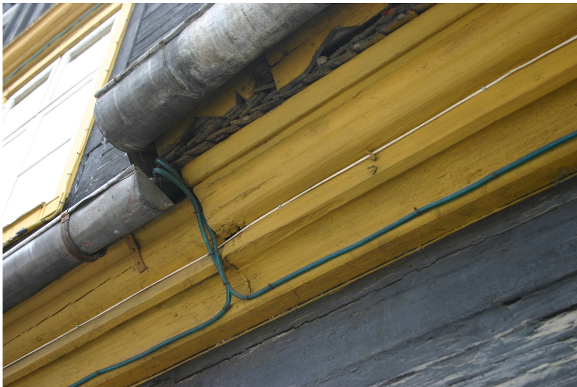
Bazniīcas_5_62010060102001_dzega1 Sākotnēja (19.gs.1.cet., līdz 1813.g.) dzega.
