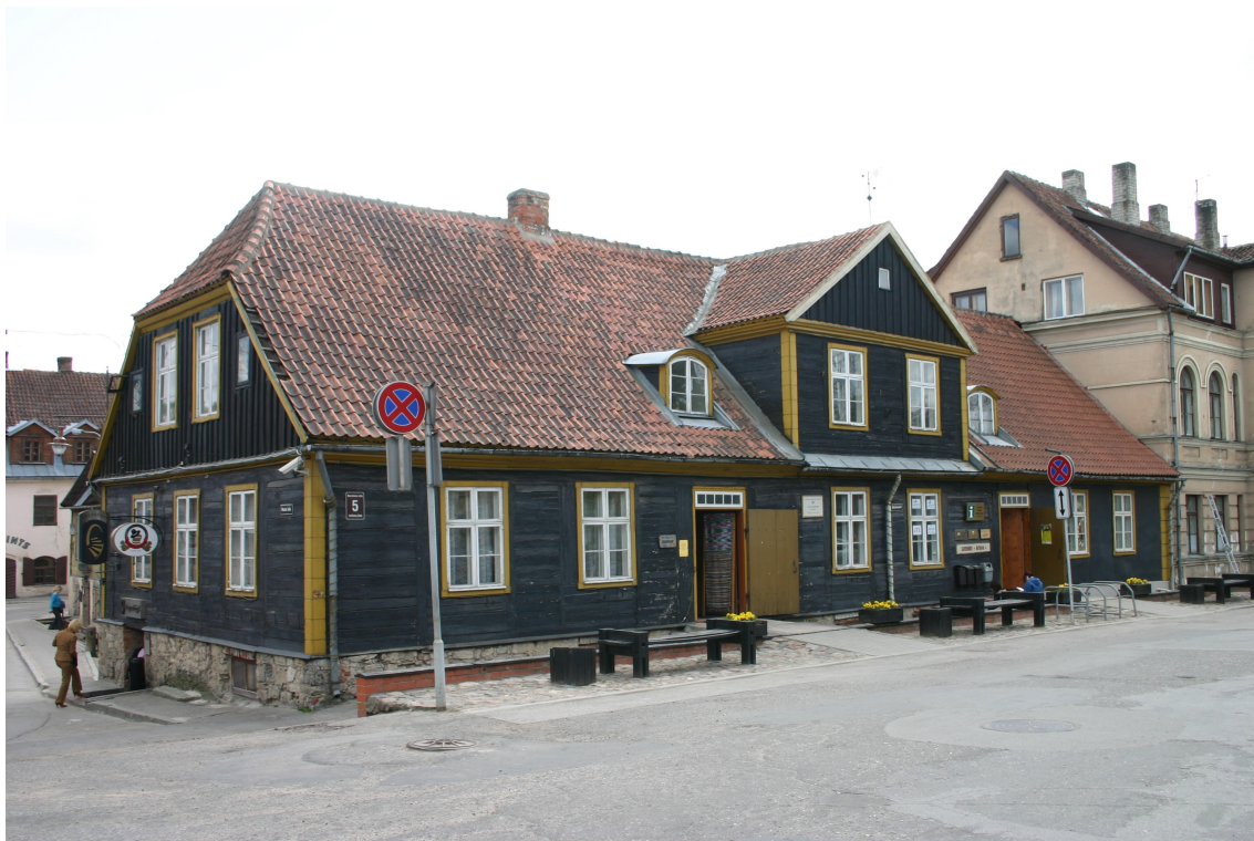
Bazniicas_5_62010060102001_fasade1 Skats uz ēku no ziemeļiem.
