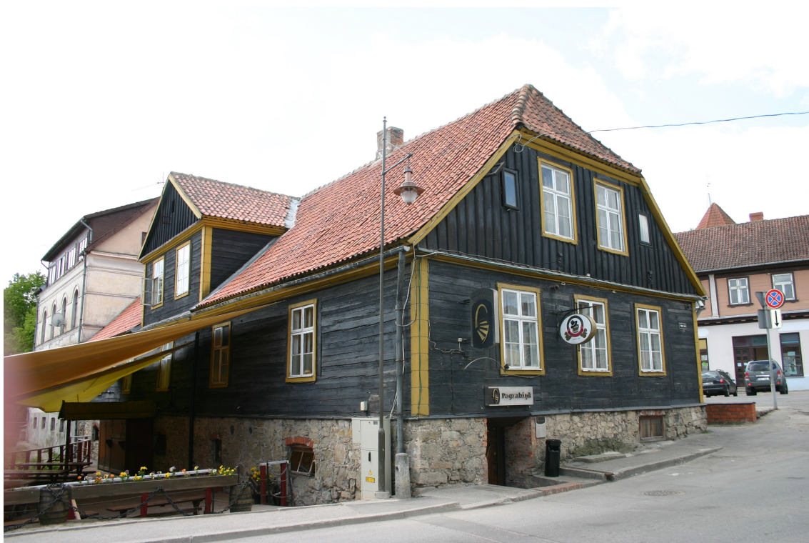
Bazniicas_5_62010060102001_fasade2 Skats uz ēku no austrumiem.
