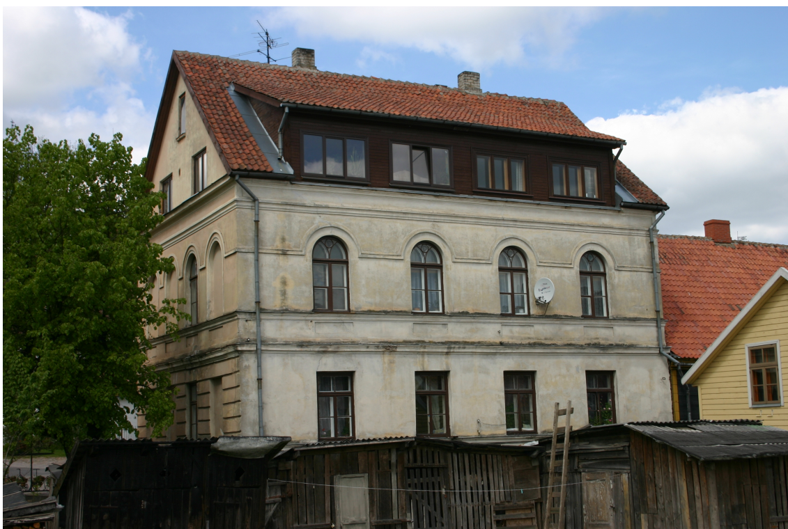
Bazniicas_3_62010060041001_fasade4 Skats uz ēku no dienvidiem.
