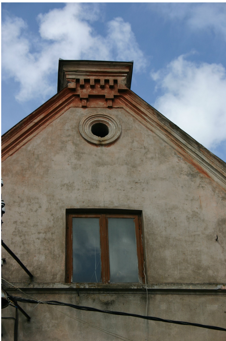
Bazniicas_12_62010060062001_fragments1 Ielas fasādes fragments ar 19.gs.beigu dekoratīvo apdari. Fasādes plaknes apmetums uzlikts 20.gs.2.pusē. Logam zudušas 19.gs.b. apmales un sandriks.
