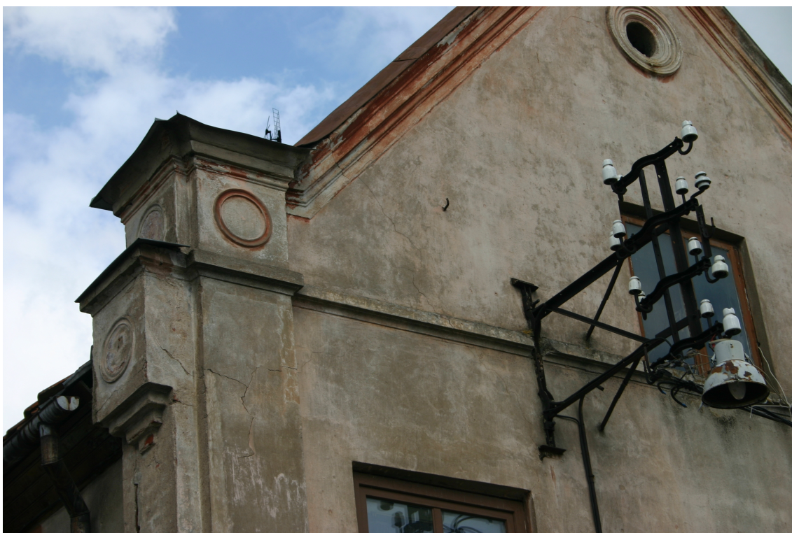
Bazniicas_12_62010060062001_fragments2 Ielas fasādes fragments ar 19.gs.beigu dekoratīvo apdari. Fasādes plaknes apmetums uzlikts 20.gs.2.pusē. Logiem zudušas 19.gs.beigu apmales un sandriki.
