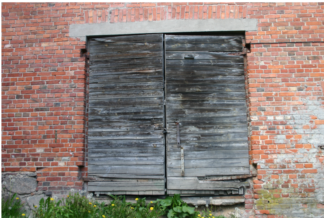
Bazniicas_11a_62010060078001_durvis1 Sākotnējas durvis ar oriģinālo aprīkojumu. 20.gs.2.pusē aila pazemināta ieliekot dzelzsbetona pārsedzi.
