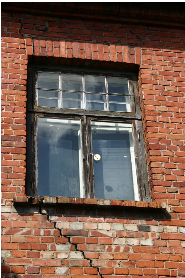
Bazniicas_11a_62010060078001_logs1 Sākotnējs (20.gs.20.gadu) 3.stāva logs ar oriģinālo aprīkojumu.
