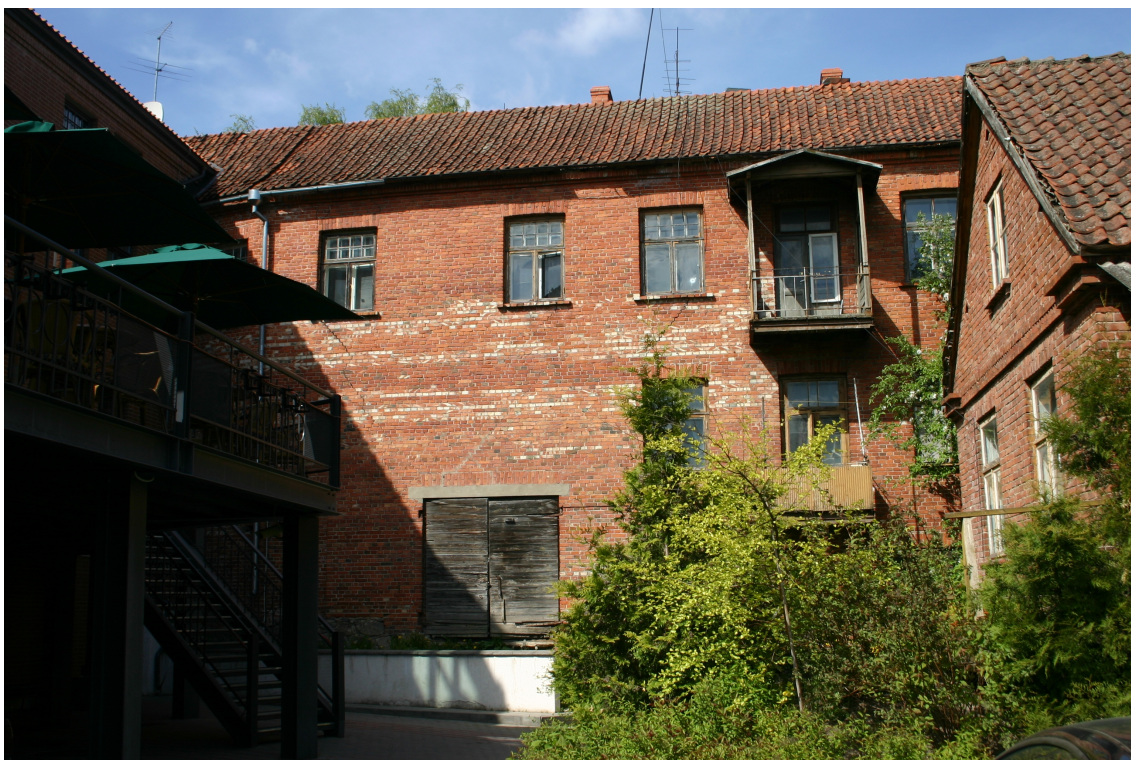
Bazniicas_11a_62010060078001_fasade2 Ēkas dienvidu fasādes fragments.
