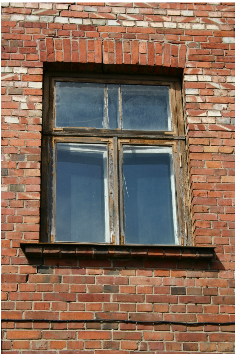
Bazniicas_11a_62010060078001_logs2 Sākotnējs (20.gs.20.gadu) 2.stāva logs ar oriģinālo aprīkojumu.
