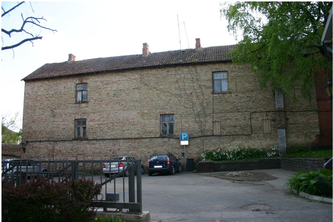
Bazniicas_11a_62010060078001_fasade3 Ēkas ziemeļu fasāde.
