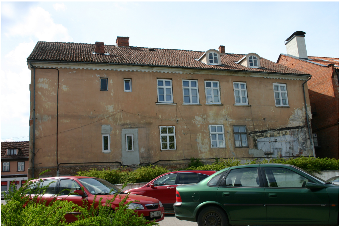
Bazniicas_9_62010060036001_fasade3 Ēkas austrumu fasāde.
