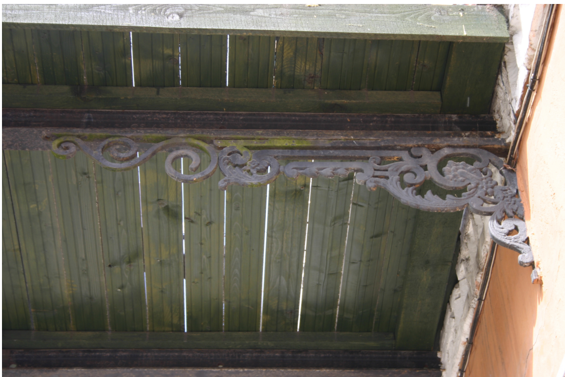
Bazniicas_9_62010060036001_detala1 Sākotnējā (19.gs.3.cet.) balkona konsole.
