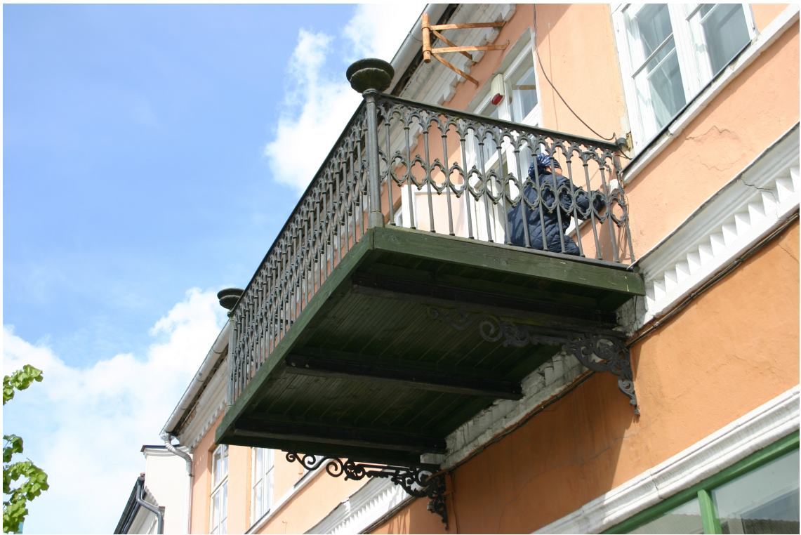
Bazniicas_9_62010060036001_fragments2 Sākotnējās (19.gs.3.cet.) balkona margas un konsoles.
