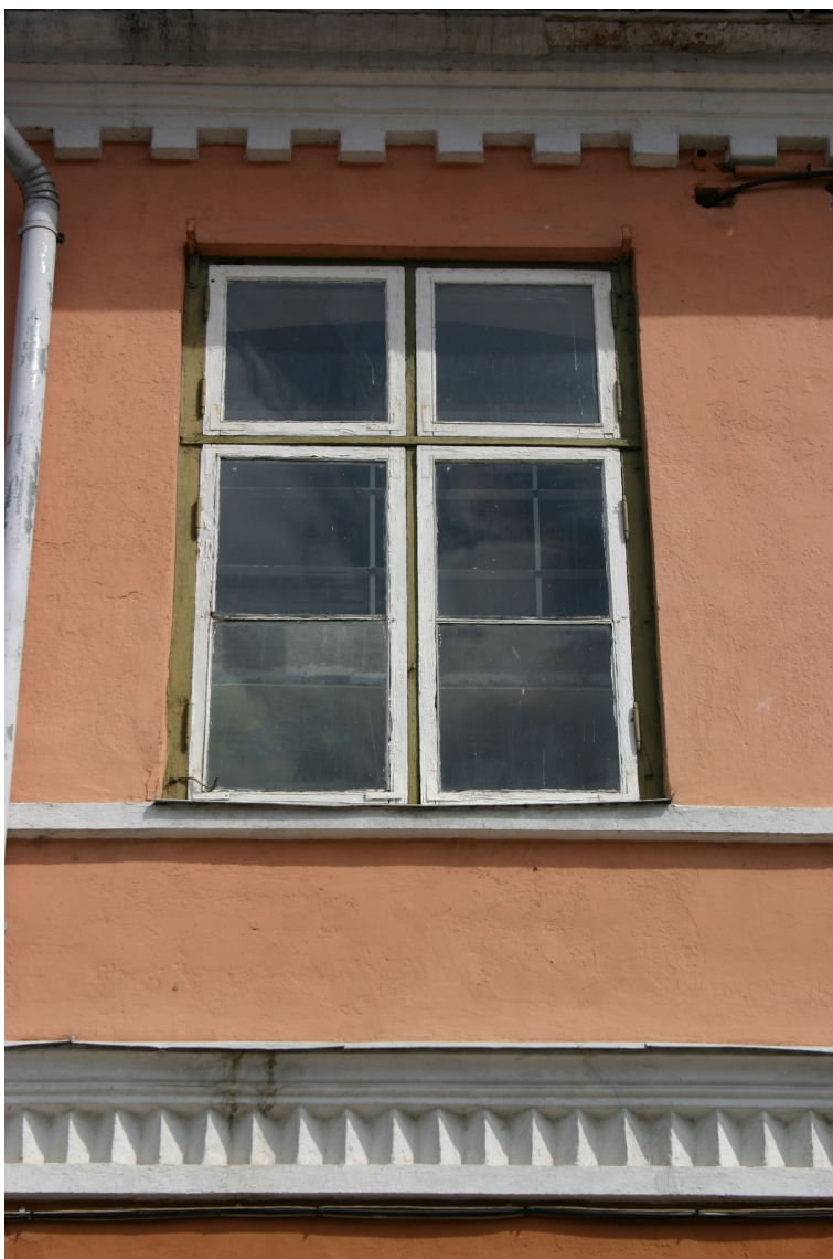
Bazniicas_9_62010060036001_logs1 Sākotnējais (19.gs.3.cet.) logs ar oriģinālo aprīkojumu.
